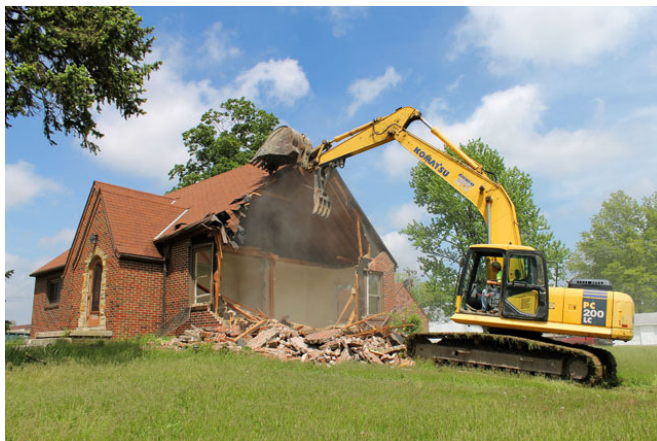
Εικόνα 15: Τροποποιημένος εκσκαφέας με πρόσθετη κάτω σιαγόνα για πιο αποτελεσματική λειτουργία(πηγή: http://www.loupiote.com/photos.shtml )
