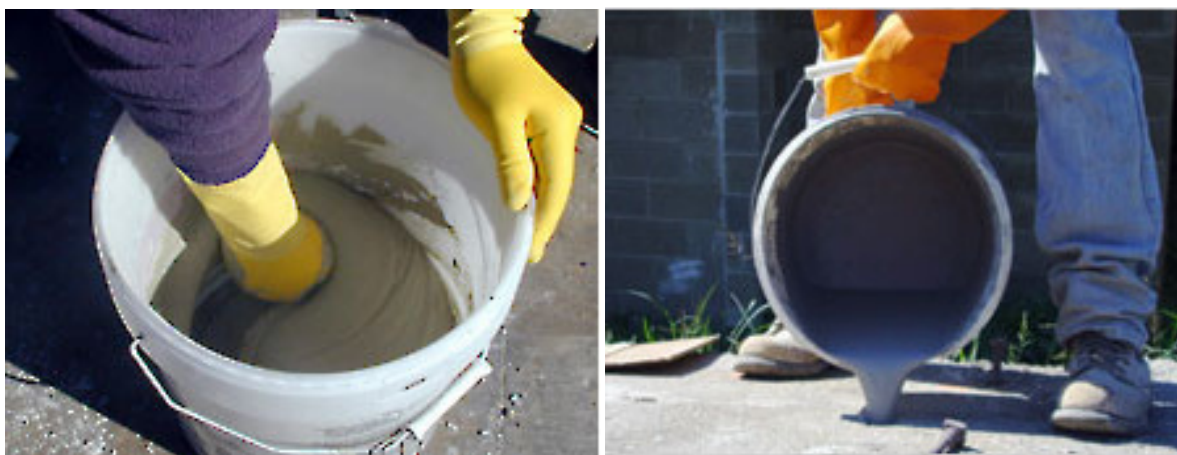
Εικόνα 21: Παρασκευή και τοποθέτηση διογκούμενου υλικού στις οπές συγκέντρωσης τάσεων.( πηγή: http://www.elebor.gr/ )
