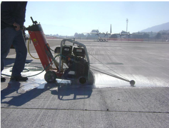
Εικόνα 10: Δισκοπρίονο επί τροχών, χρησιμοποιείται σε περιπτώσεις αφαίρεσης μαρμάρινων επιφανειών δαπέδων όπου χρειάζεται καθαρή τομή για ενδεχόμενη επαναχρησιμοποίηση (πηγή: ΠΕΤΕΠ 15-02-01-01)
