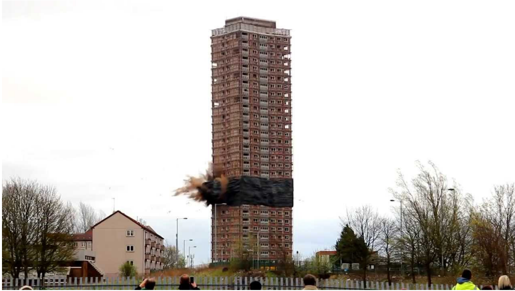
Εικόνα 2: Κατεδάφιση κτιρίου στη Γλασκώβη το 2013 (πηγή: https://www.youtube.com/watch?v=mefZ383hLjo )
