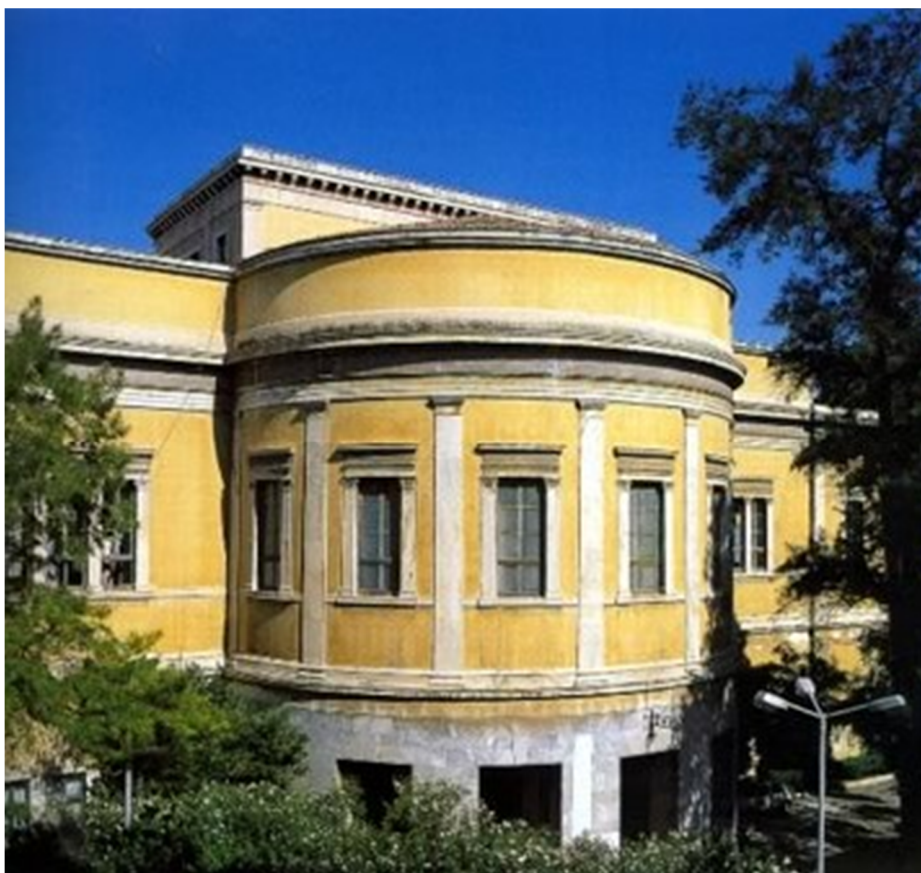
Εξωτερική όψη της αίθουσας τελετών από τον προαύλιο χώρο
