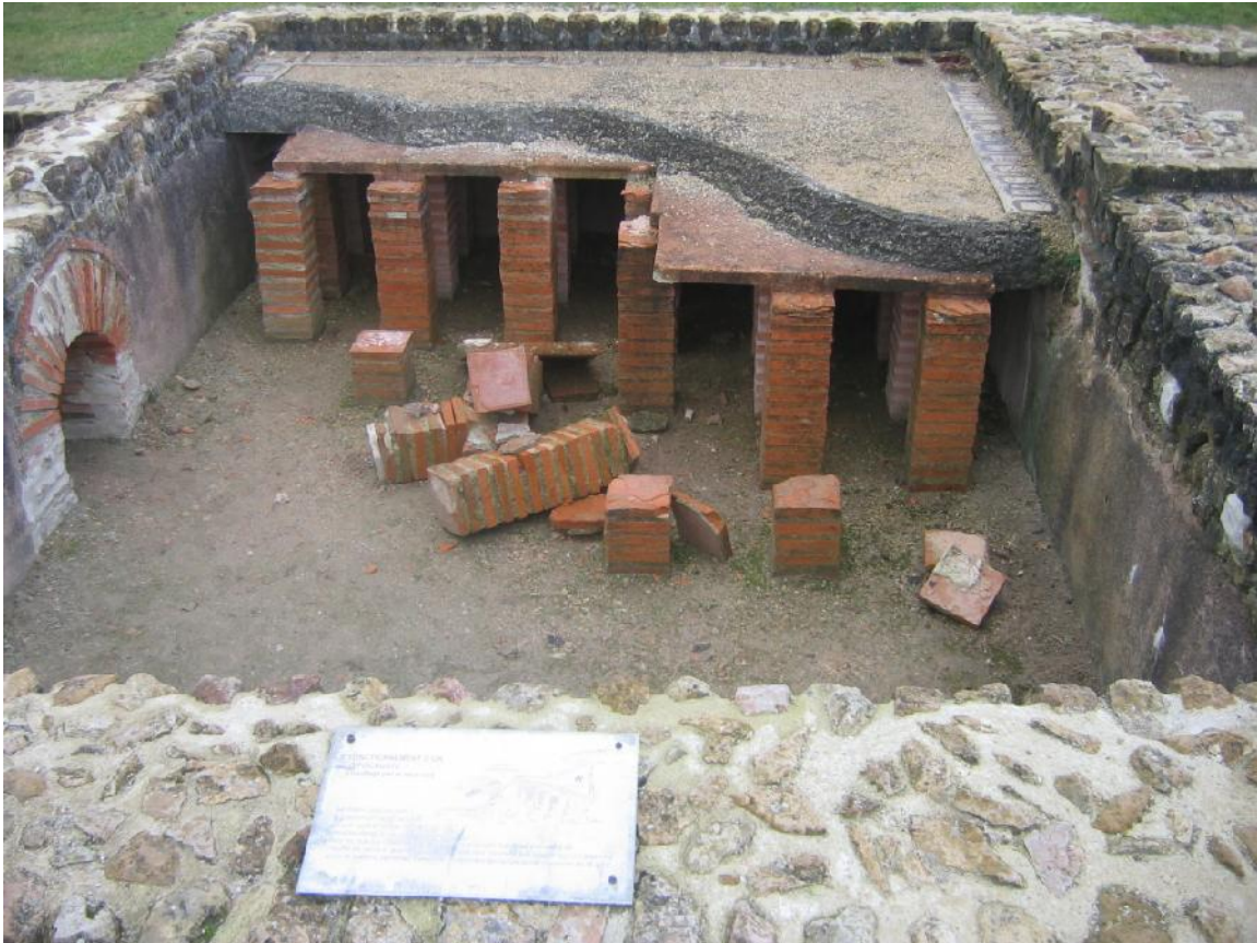
Εικόνα 2.1. Σχηματική αναπαράσταση υπόκαυστων
