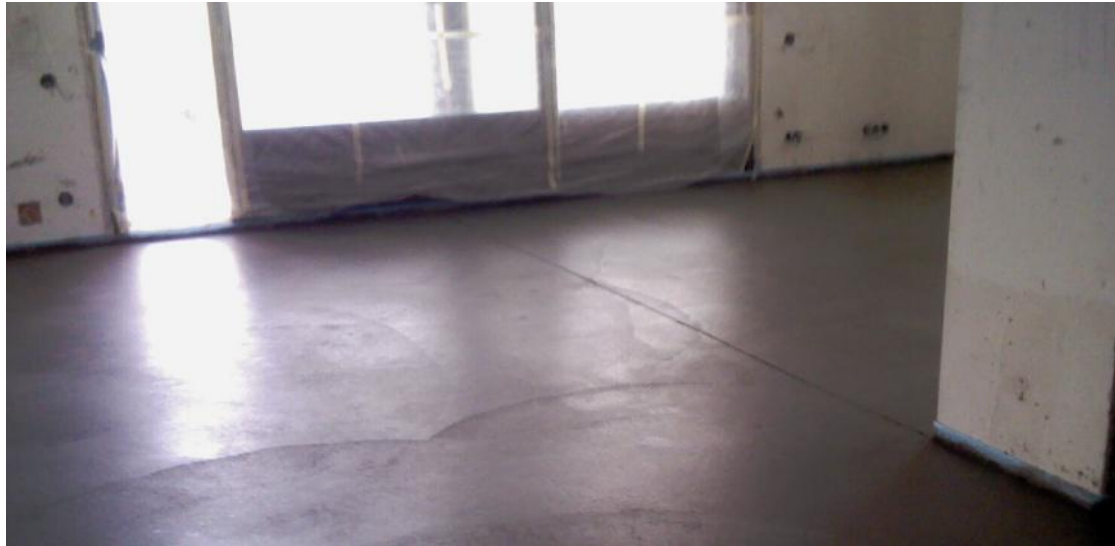
Εικόνα 2.15. Αρμός διαστολής στο θερμοπετό
