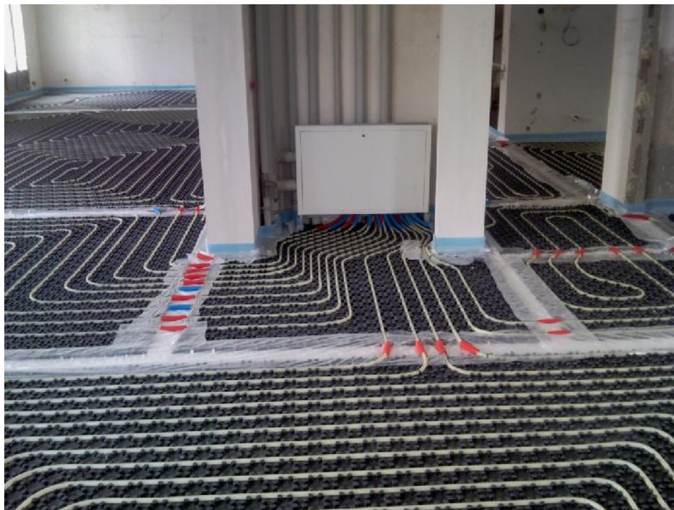
Εικόνα 2.14. Αρμοί διαστολής κατά την τοποθέτηση της ενδοδαπέδιας θέρμανσης
