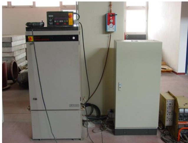
Εικόνα 5.2 Η κονσόλα ελέγχου του ρομποτικού βραχίονα
