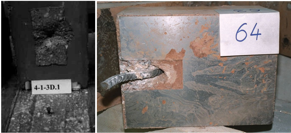
Σχήμα Δ.1.1.4: Κατηγορία βλάβης 3: Εξόλκευση του οπλισμού από το προστιθέμενο σκυρόδεμα, θραύση του σκυροδέματος κάτω από το βλήτρο (Choi et al., 1999, Randl, 2007).
