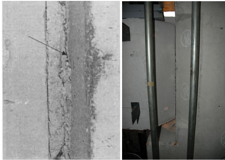
Σχήμα Δ.1.1.1: Κατηγορία βλάβης 1: Δημιουργία ρωγμής κατά μήκος της διεπιφάνειας (Valluvan, 1993, Παρούσα Διατριβή).
