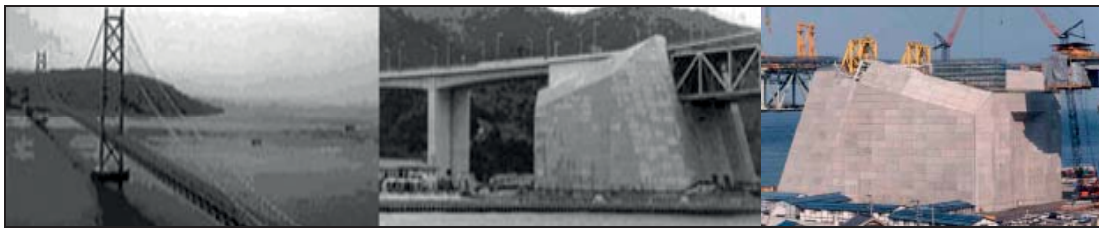
Σχήμα 8 Βάσεις αγκύρωσης γέφυρας Akashi-Kaikyo, Ιαπωνία [πηγή: Okamura and Ouchi (2003) ]
