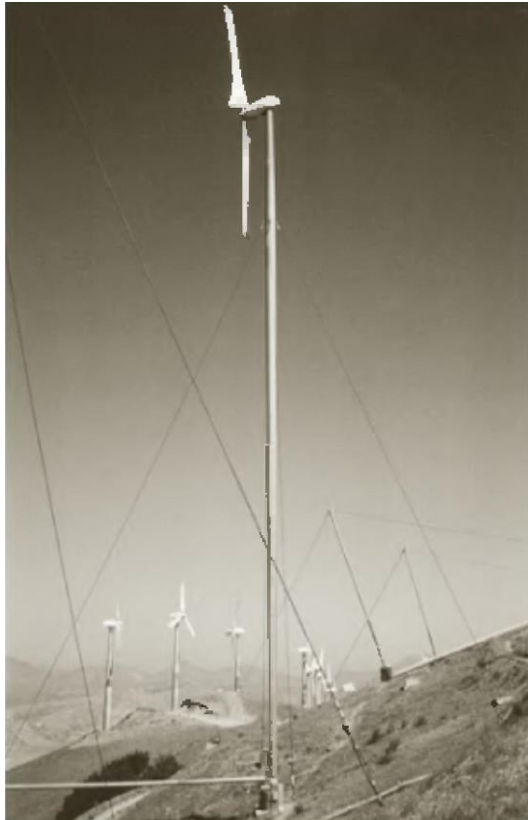
Σχήμα 1-9: χαλύβδινοι σωληνωτοί πυλώνες με αγκύρια [1]
