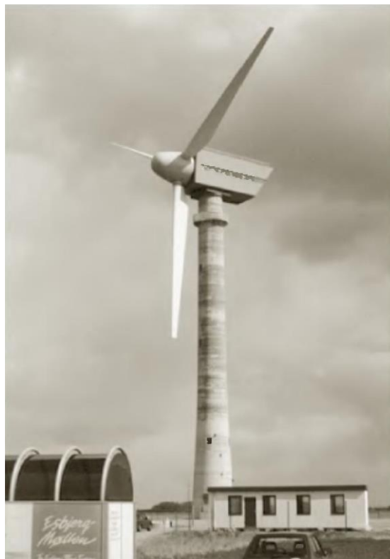
Σχήμα 1-8: πυλώνας από οπλισμένο σκυρόδεμα πειραματικής ανεμογεννήτριας [1]
