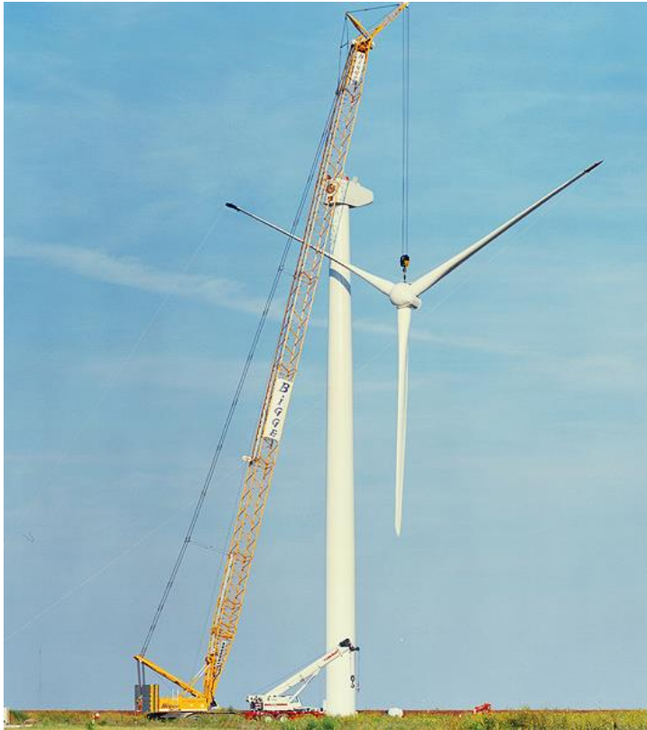
Σχήμα 1-15: ανέγερση πτερυγίων (πηγή: www.bigge.com )
