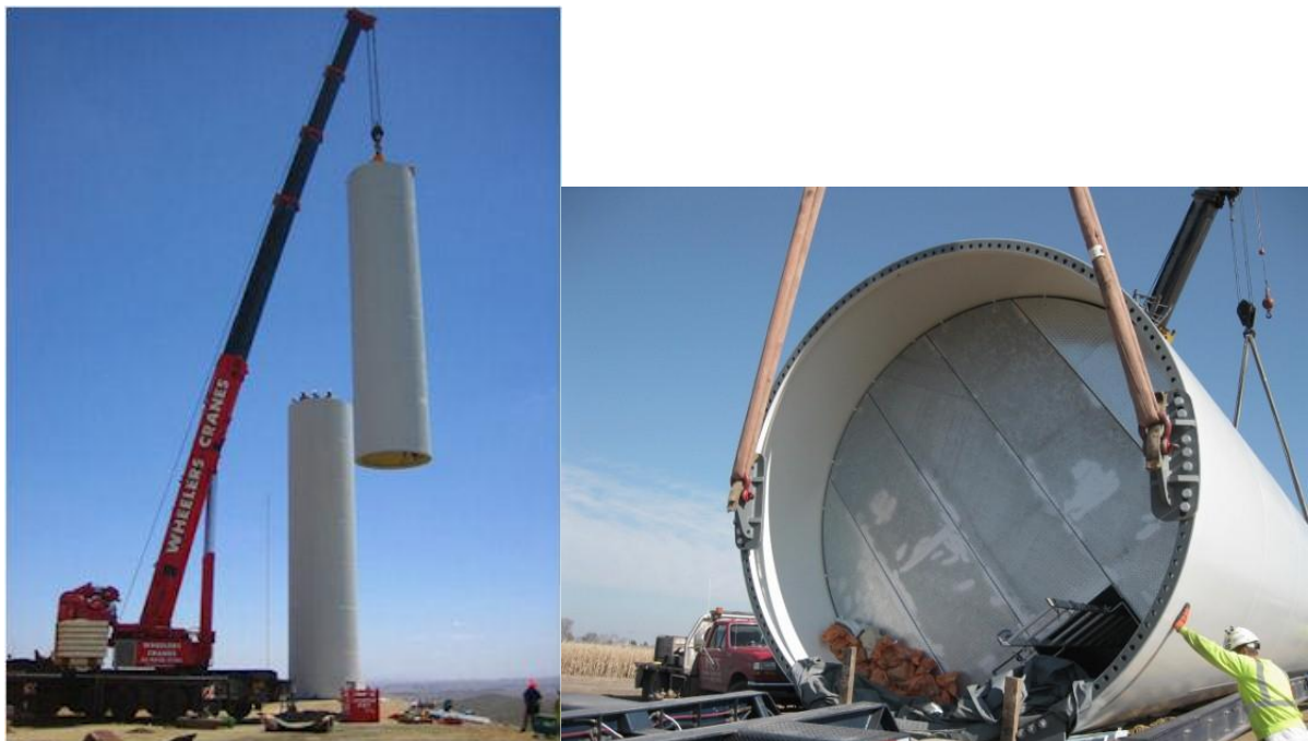
Σχήμα 1-14: ανέγερση τμήματος πυλώνα (πηγή: www.windlab.com & diamondtowerservice.com )
