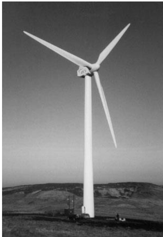
Σχήμα 1-3: ανεμογεννήτρια οριζόντιου άξονα [2]
