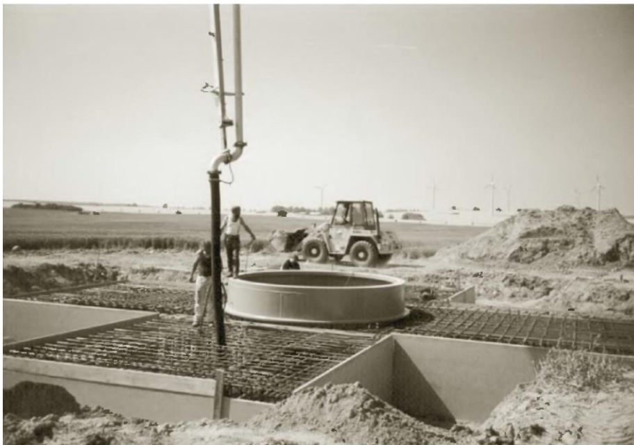
Σχήμα 1-18: θεμελίωση μεγάλης εμπορικής ανεμογεννήτριας [1]
