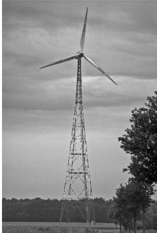
Σχήμα 1-7: δικτυωτός πυλώνας ανεμογεννήτριας Vestas V80 [1]
