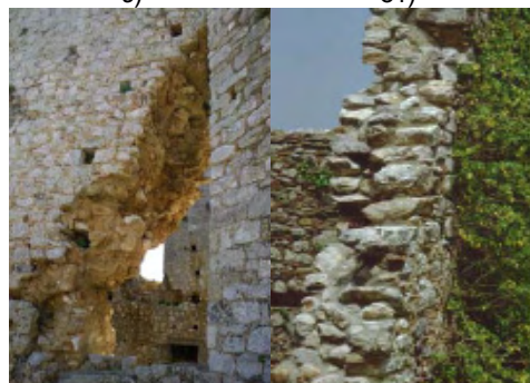
Εικόνα 1. Τρίστρωτες τοιχοποιίες (Vintzileou 2009).
