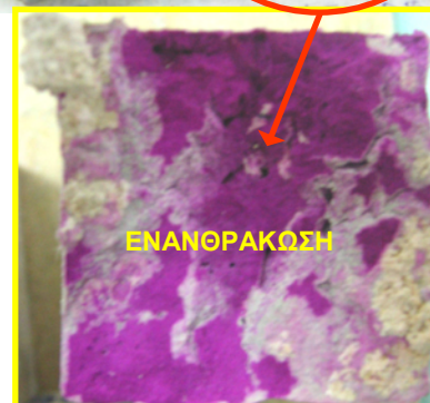
Εικόνα 164. Ενανθράκωση σε διατομή αρμού τραβερτίνη/τριμερούς ενέματος μηλαϊκής γης.
