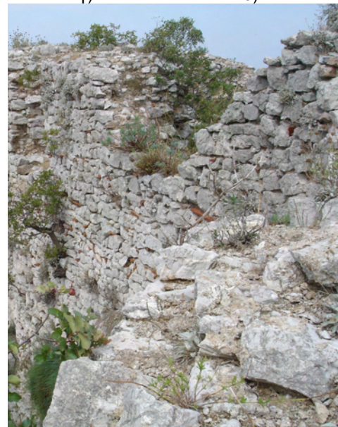
Εικόνα 2. Τρίστρωτες τοιχοποιίες (αρχείο Χ.-Ε. Αδάμη).
