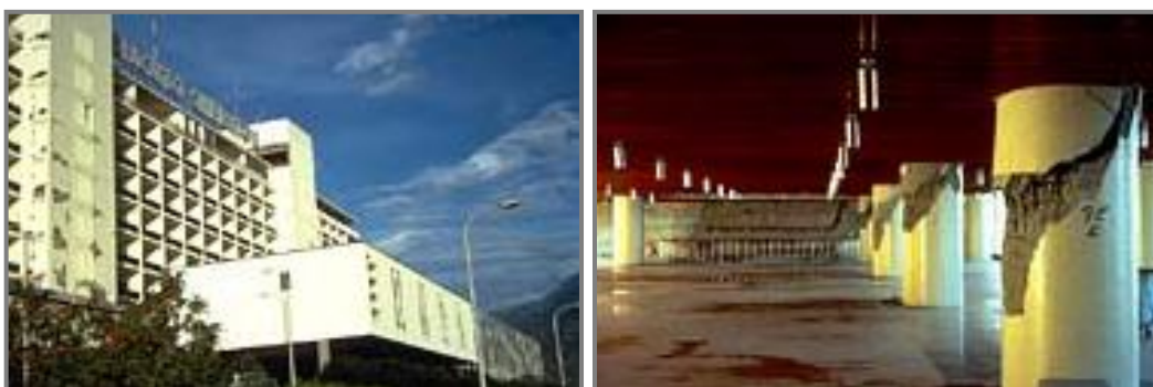
Σχήμα 5. (α) Γενική άποψη του 10-όροφου ξενοδοχείου στη Βενεζουέλα, που υπέστη βλάβες μετά τον σεισμό του 1967. (β) Βλάβες στα υποστυλώματα (διάμετρου 1,10m) του 3 ου ορόφου, λόγω της ασυνέχειας των τοιχωμάτων (Bertero, 1997)
