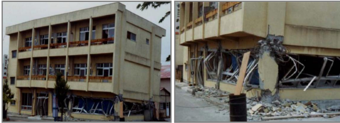
Σχήμα 3. (α) Γενική άποψη των βλαβών σε τριώροφο κτίριο από οπλισμένο σκυρόδεμα. (β) Βλάβη σε περιμετρικό υποστύλωμα λόγω ασύμμετρης κατανομής της δυσκαμψίας, κατά τη διάρκεια σεισμού στην Ιαπωνία το 1978 (DO SOO MOON, 2012)
