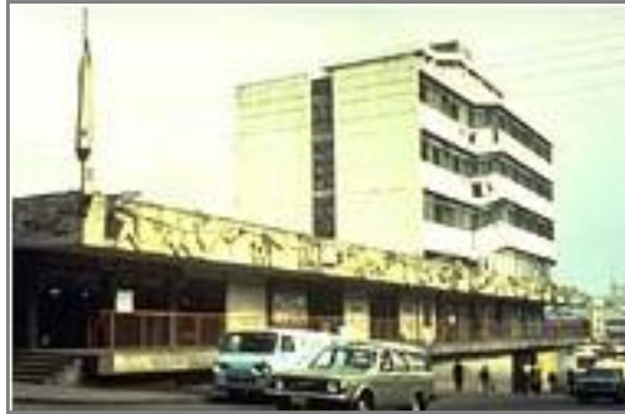
Σχήμα 1. Γενική άποψη 6-όροφου ξενοδοχείου στην περιοχή της Γουατεμάλα, που αστόχησε στρεπτικά στον 2 ο όροφο, λόγω σεισμού που συνέβη το 1976 στην περιοχή (Bertero, 1997)
