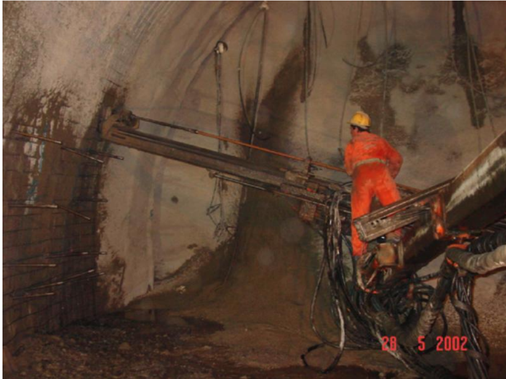
Τοποθέτηση αγκυρίων SELF-DRILLING
