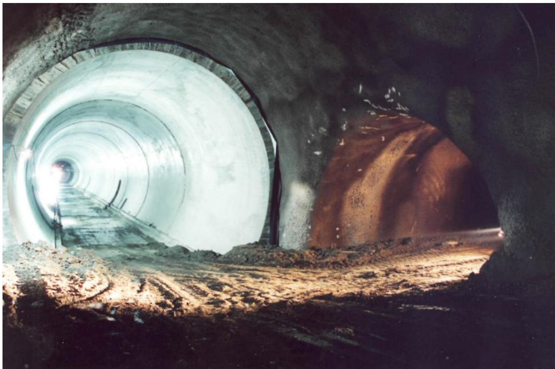
Κατασκευή συνδετήριας σήραγγας
