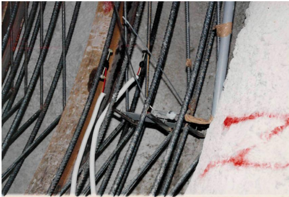
Τοποθέτηση υδραυλικών κυψελών πίεσης (pressure cells) και συσκευών μέτρησης παραμόρφωσης (strain gauges).
