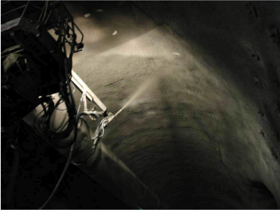
Τοποθέτηση εκτοξευόμενου σκυροδέματος
