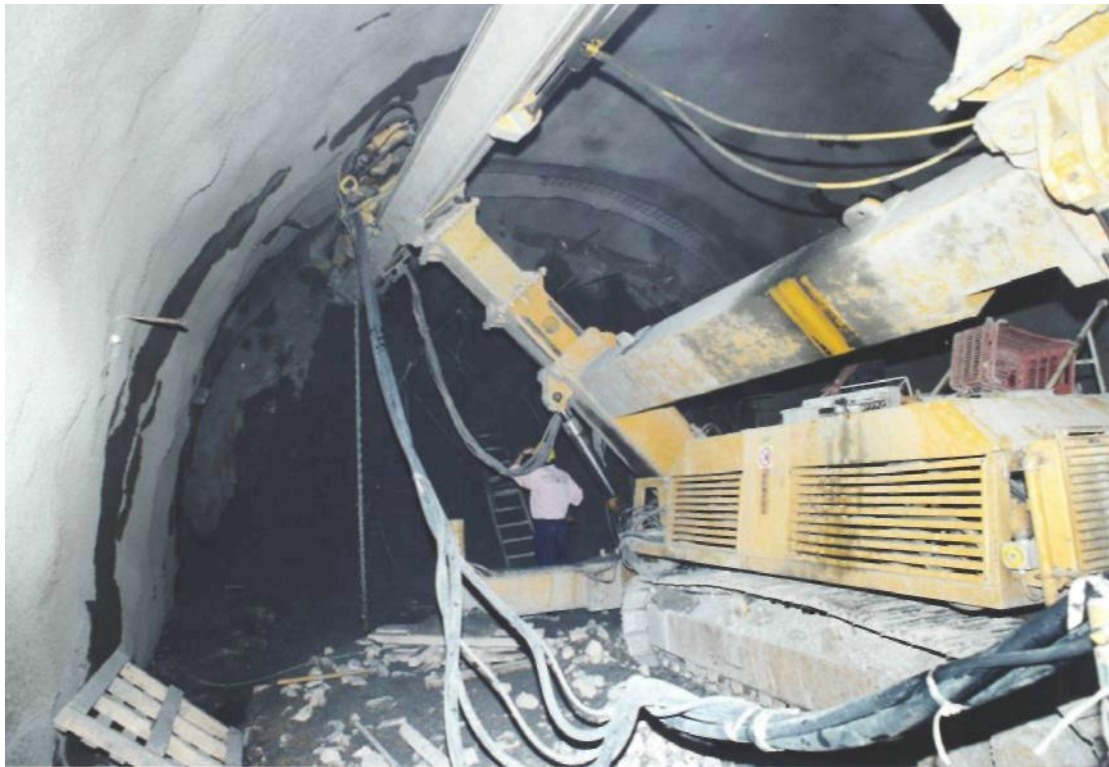
Κατασκευή σωλήνων προπορείας ( FOREPOLING)
