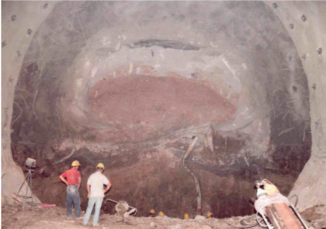
Εκσκαφή για την αποκατάσταση. Δεξιός κλάδος χ.θ. 6+520
