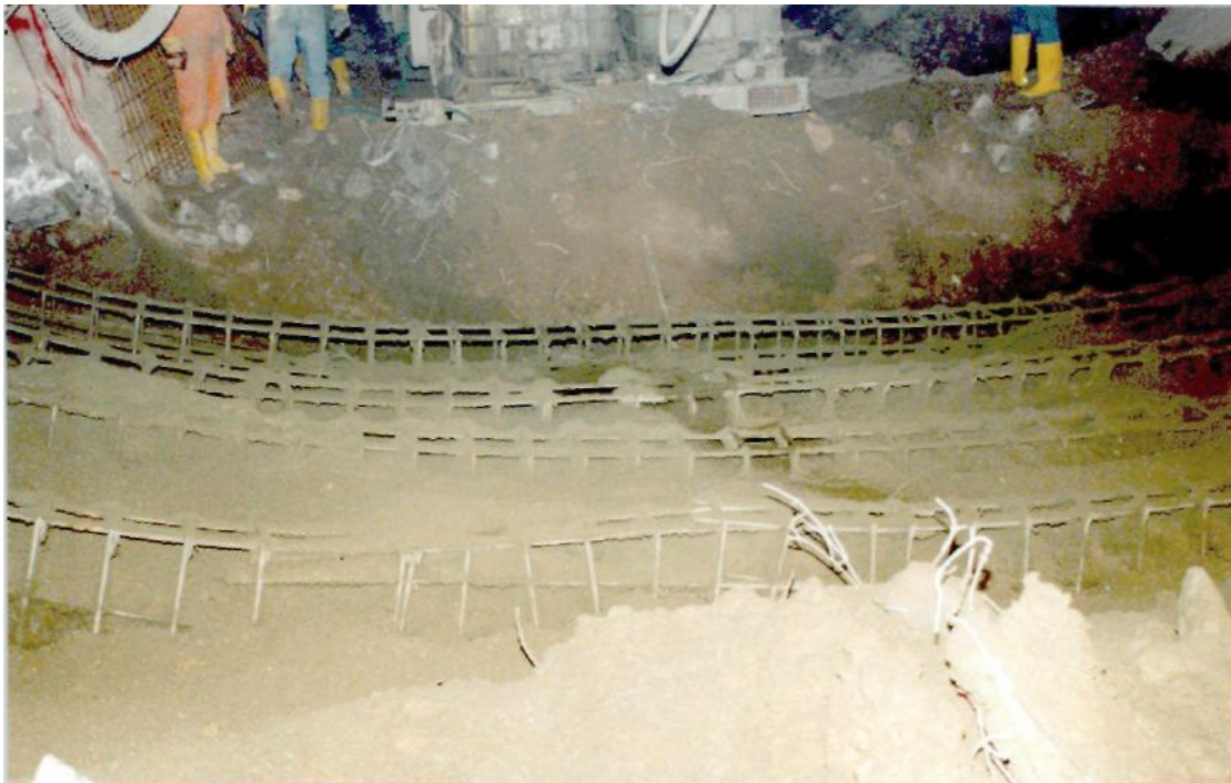
Νότιο Μέτωπο - Δεξιός Κλάδος: αποκατάσταση invert.
