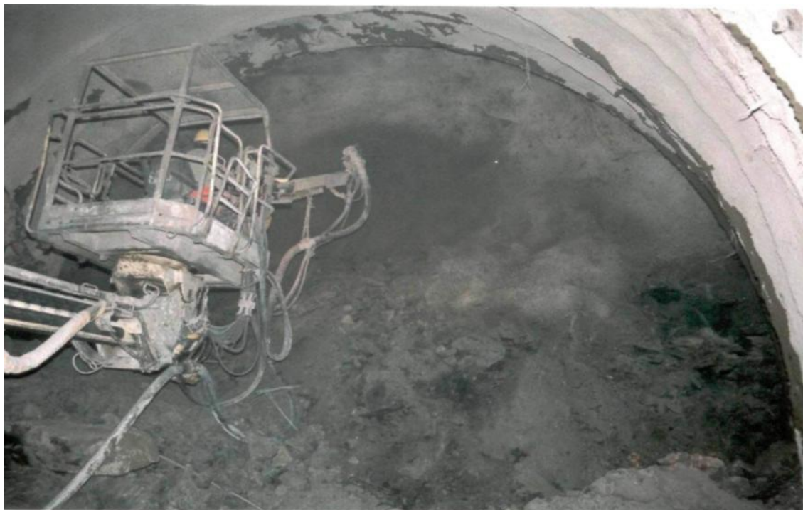
Τοποθέτηση εκτοξευόμενου σκυροδέματος
