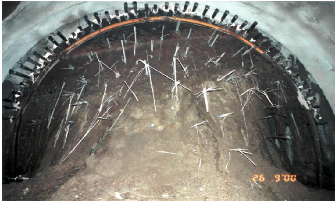
Αντιστήριξη μετώπου με σωλήνες προπορείας (FOREPOLING) και fiber-glass αγκύρια
