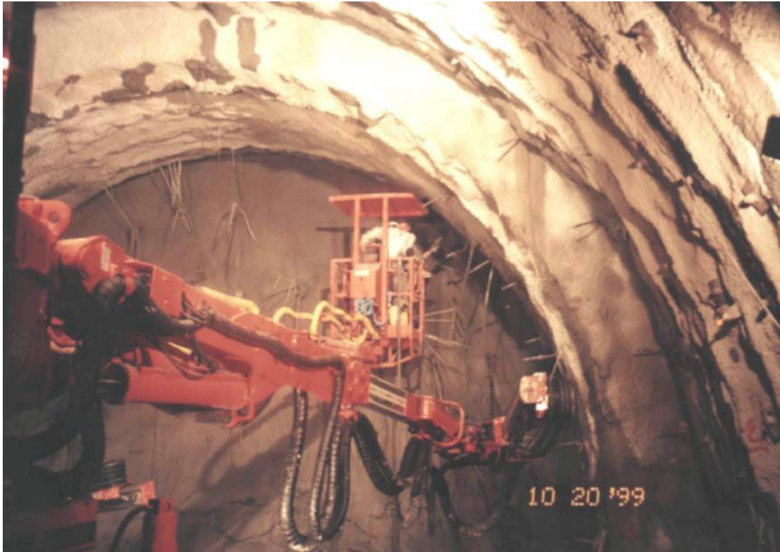
Τοποθέτηση εκτοξευόμενου σκυροδέματος
