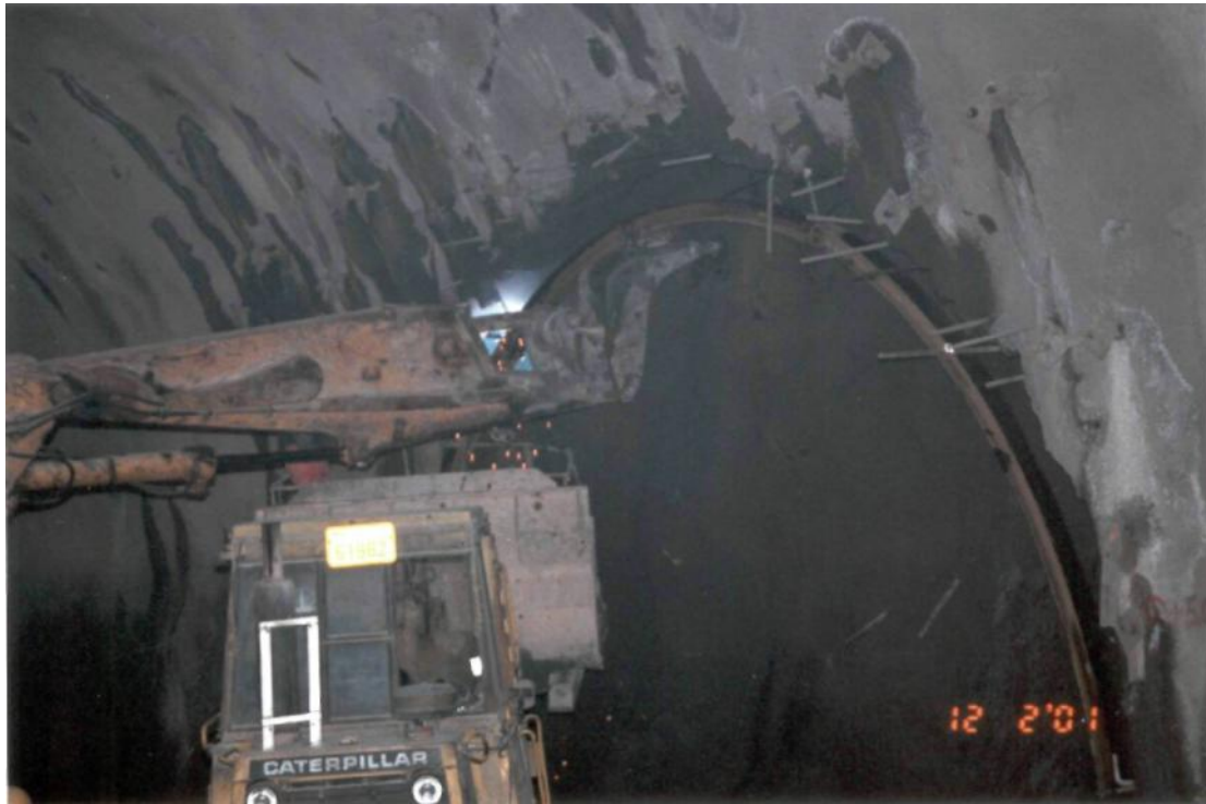
Κατασκευή συνδετήριας σήραγγας
