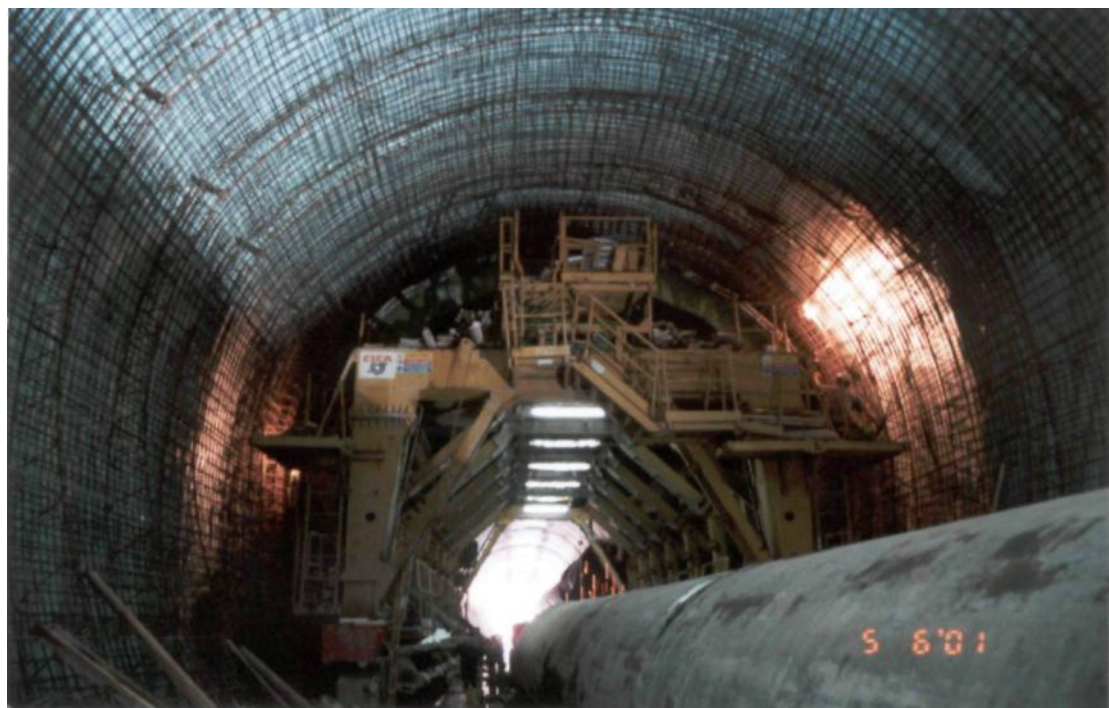
Κατασκευή τελικής επένδυσης
