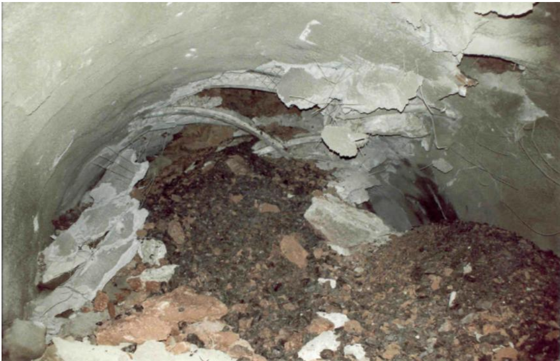
Θραύσεις gunite στην οροφή. Δεξιός κλάδος χ.θ. 6+560 - 6+590
