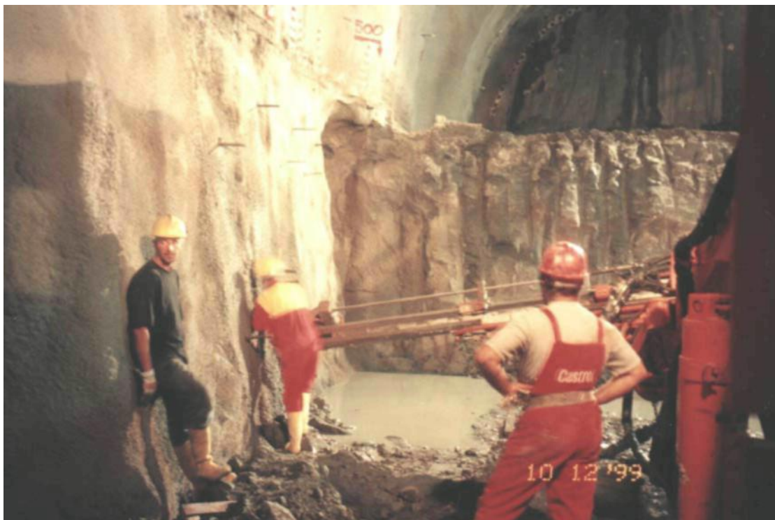
Τοποθέτηση αγκυρίων Β' φάσης
