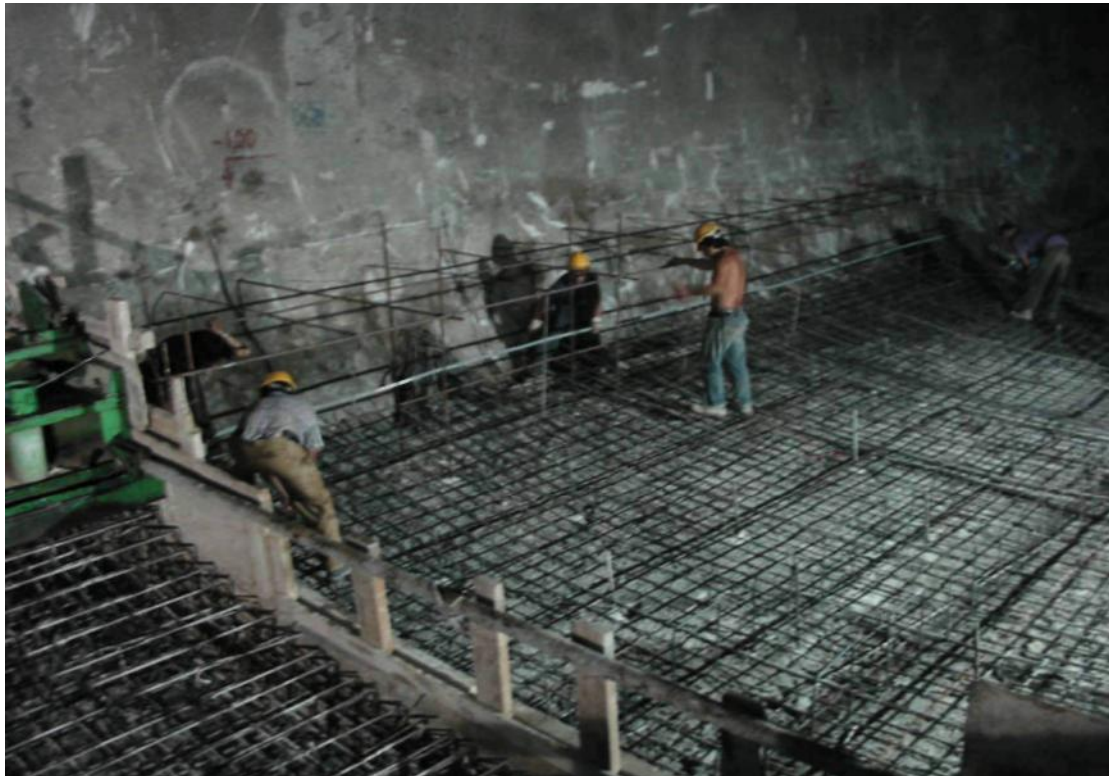
Κατασκευή δαπέδου τελικής επένδυσης
