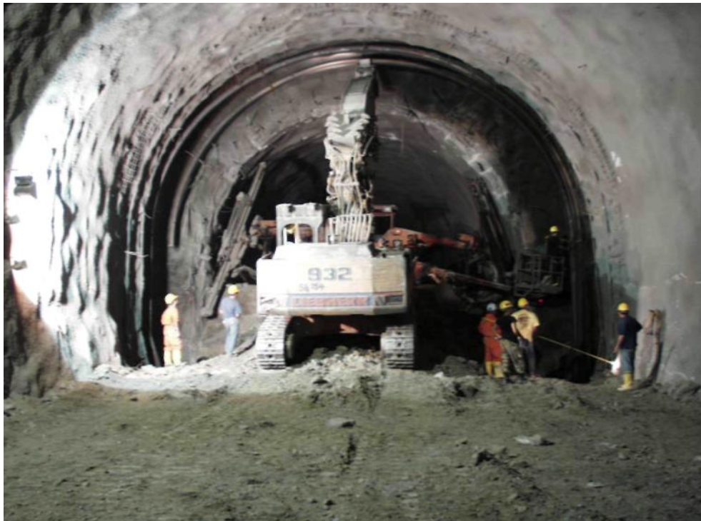
Εργασίες αποκατάστασης γεωμετρίας διατομής
