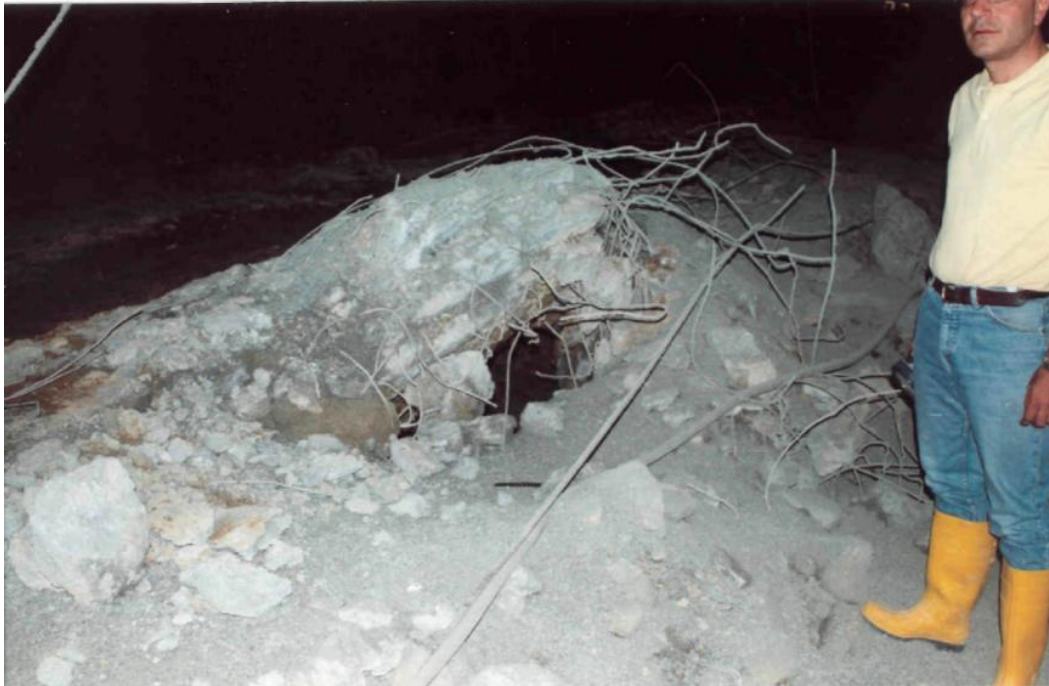
Ανύψωση και θραύση του προσωρινού invert. Δεξιός κλάδος - χ.θ.6+520
