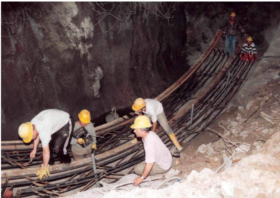
Τοποθέτηση πλαισίων και δικτυωμάτων στη φάση της αποκατάστασης.
