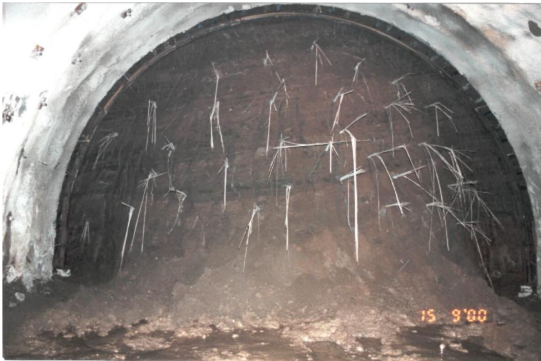
Αντιστήριξη μετώπου με fiber-glass αγκύρια
