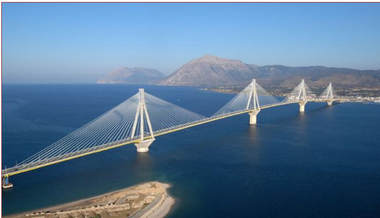
1-22 Καλωδιωτή γέφυρα Ρίο-Αντίρριο με τροποποιημένο σχεδιασμό βεντάλιας
