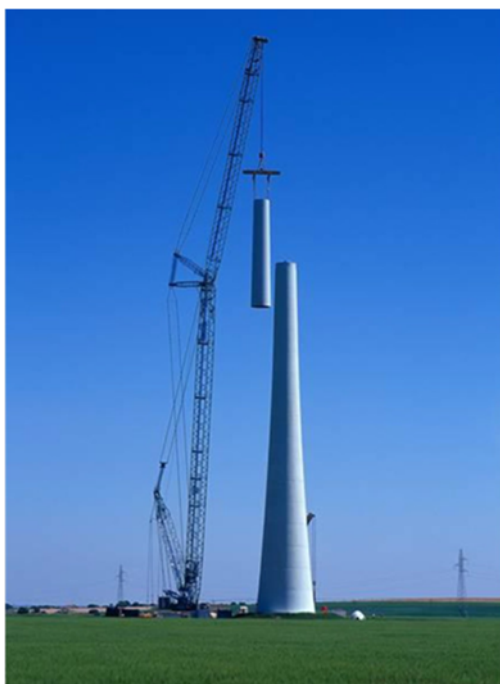
Σχήμα 3-1: Ανέγερση πυλώνα με γερανό
