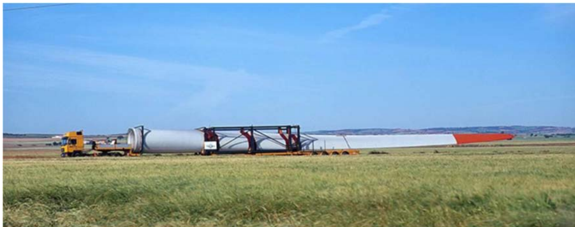
Σχήμα 3-3: Μεταφορά τμημάτων οδικώς στο χώρο ανέγερσης
