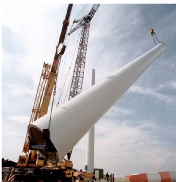
Σχήμα 1-8: Ανέγερση σωληνωτού πυλώνα από χάλυβα
