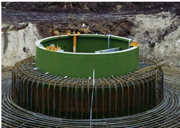
Σχήμα 3-2: Θεμελίωση πυλώνα
