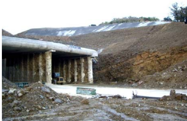
Εικόνα 6-15 : Η ψαμμιτική φάση του φλύσχη σε όρυγμα για την κατασκευή cut & cover της Εγνατίας. Διακρίνεται η ισχυρή συγκρότηση του σχηματισμού, τόσο στα πρανή, όσο και στα ευσταθή υπολείμματα πετρώματος μεταξύ διαδοχικών πασσάλων της ενδιάμεσης συστοιχίας
