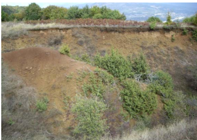
Εικόνα 6-8 : Υλικά του μανδύα αποσάθρωσης του φλύσχη που, στη συγκεκριμένη θέση, αποκτούν αυξημένο πάχος και εμφανίζουν ισχυρή διάβρωση
