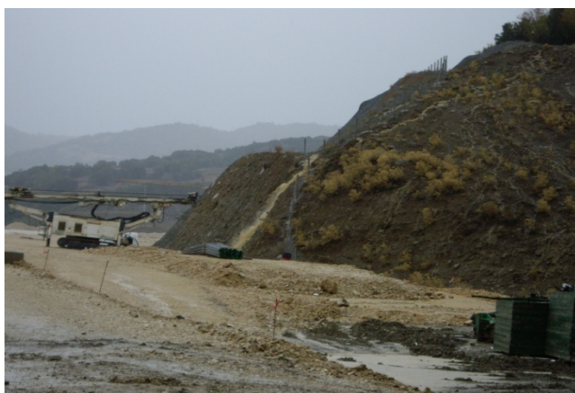
Εικόνα 6-7 : Υλικά επιχωματώσεων της Εγνατίας οδού στην περιοχή Βασιλικής
