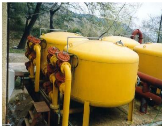
Εικόνα 18: Ταχυδιυλιστήρια Γοργοποτάμου
