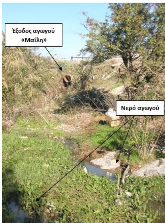
Εικόνα 2.3 Άποψη πλημμυρικής κοίτης π. Ασωπού που εκβάλλει ο αγωγός «Μαΐλη».
