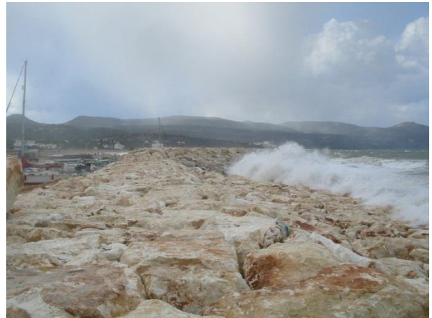
Εικόνα 4.9: Θωράκιση νέου λιμένα Λατσειού
