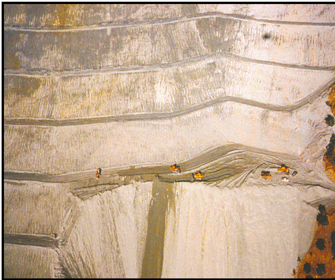
Εικόνα 5.2. Αποκατάσταση μεταλλείου σε βαθμίδες.
