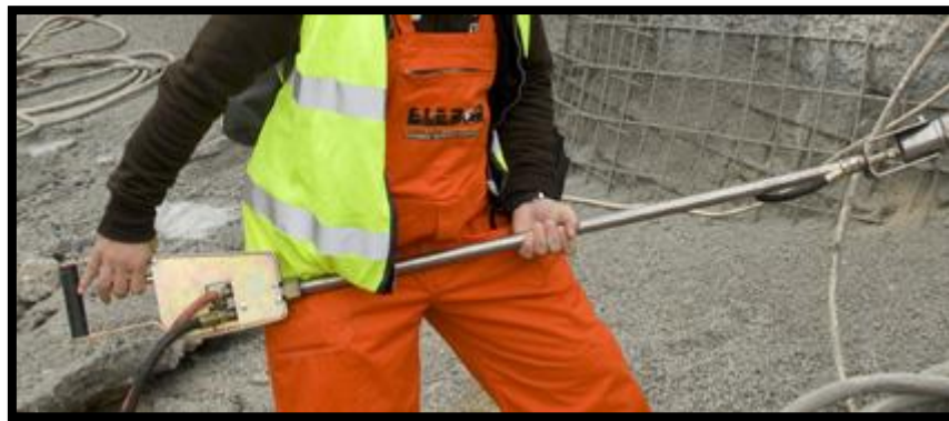
Εικόνα 2.21: Τοποθέτηση αγκυρίων τριβής swellex
