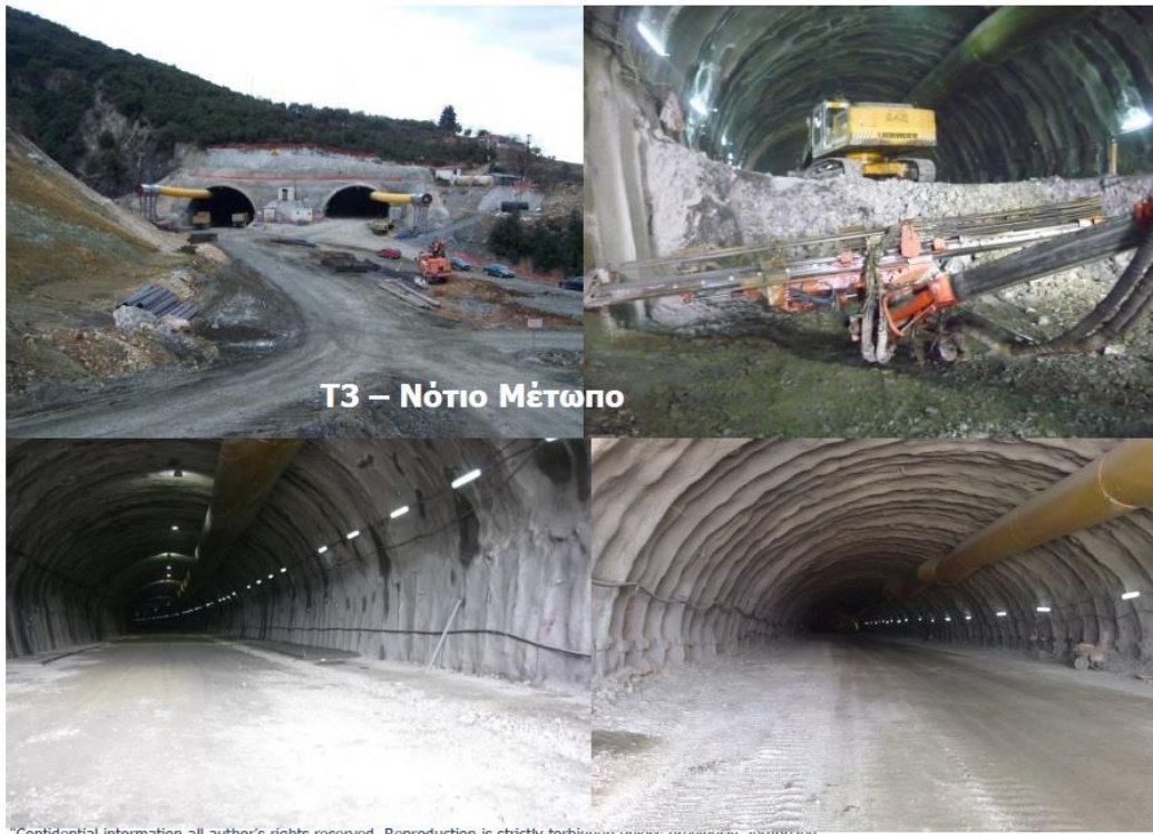
Εικόνα 2.3: Σήραγγα T3 - Νότιο Μέτωπο (Πηγή: Παρουσίαση Έργου στον Τύπο από την εταιρία Αυτοκινητόδρομος Αιγαίου)
