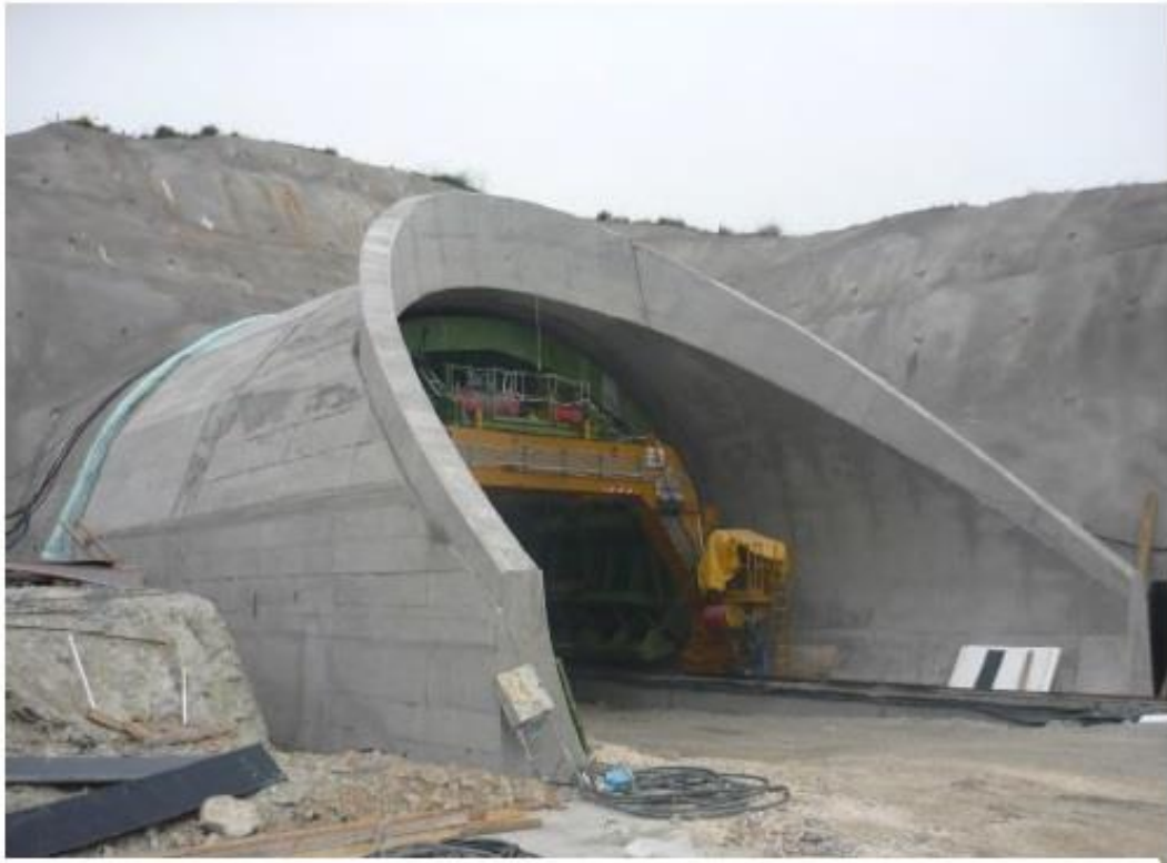
Εικόνα 2.1: Σήραγγα T1 - Νότιο Μέτωπο (Παρουσίαση Έργου στον Τύπο από την εταιρία Αυτοκινητόδρομος Αιγαίου)
