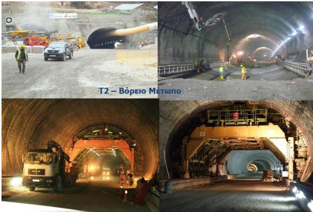
Εικόνα 2.2: Σήραγγα T2 - Βόρειο Μέτωπο (Παρουσίαση Έργου στον Τύπο από την εταιρία Αυτοκινητόδρομος Αιγαίου)
