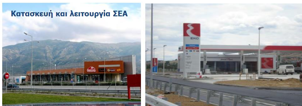
Εικόνα 2.4: Κατασκευή και Λειτουργία ΣΕΑ (Πηγή: Παρουσίαση Έργου στον Τύπο από την εταιρία Αυτοκινητόδρομος Αιγαίου)
