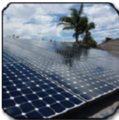
Εικόνα 12: Σκίαση φωτοβολταϊκών από φοινικόδενδρα
