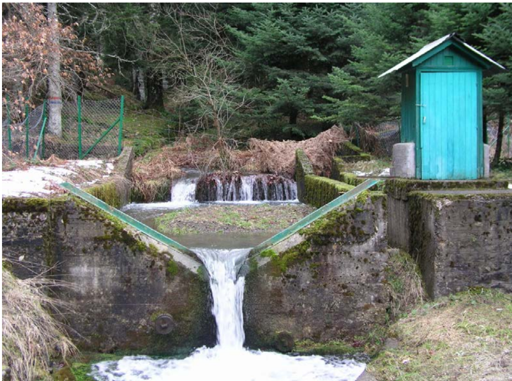
Εικόνα 2.7: Υδρομετρικός σταθμός με τριγωνικό εκχειλιστή στην έξοδο της πειραματικής λεκάνης (Πηγή: ΙΜΔΟ&ΤΔΠ)
