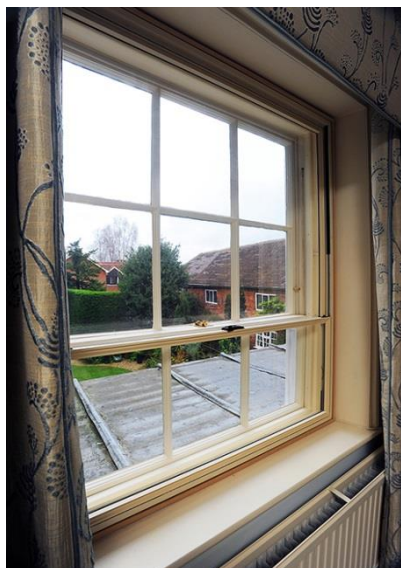
Εικόνα 9: Εφαρμοσμένο παράδειγμα δευτερεύοντος συστήματος υαλοπίνακα, σε κατοικία.
