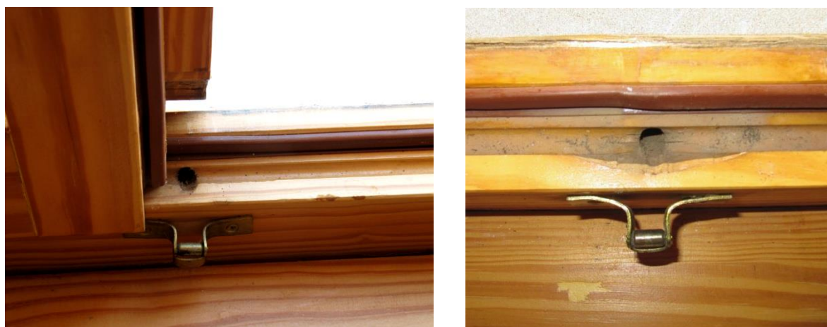
Εικόνα 25: Αυτοσχέδια τρύπα σε ξύλινο κούφωμα. Απόψεις από διαφορετικό παράθυρο (αριστερά και δεξιά).
