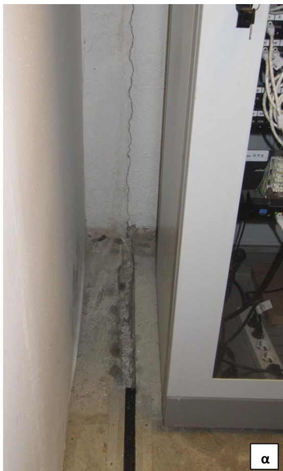
Εικόνα 27: Χώροι με ηλεκτρομηχανολογικά συστήματα. α, β,) Οι τρύπες που δεν έχουν καλυφθεί αποτελούν θερμογέφυρες και αιτία για περαιτέρω προβλήματα.
