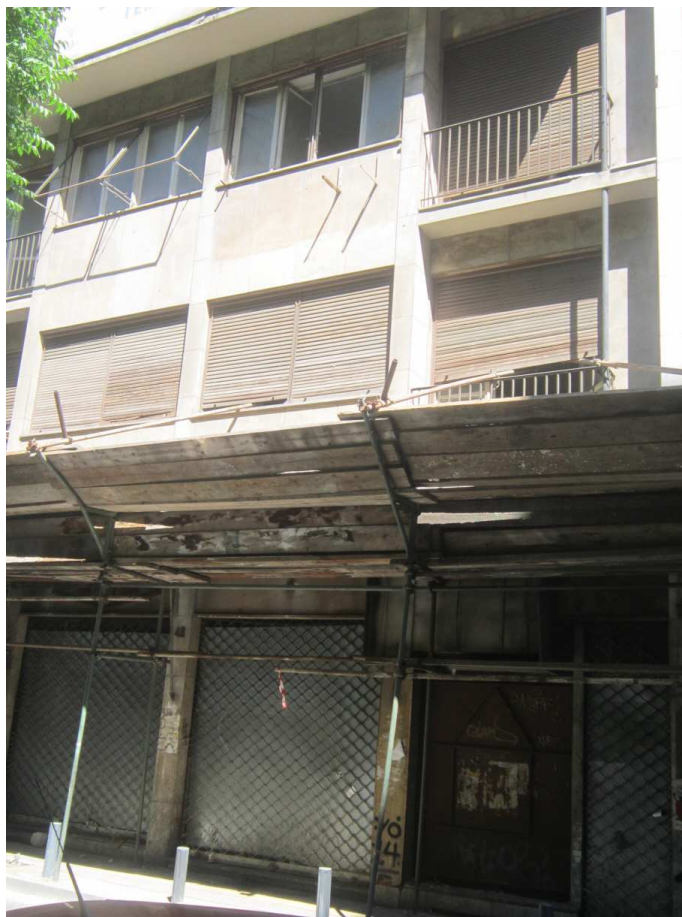
Εικόνα 18: πρόσοψη κτηρίου της οδού Μενάνδρου 48
