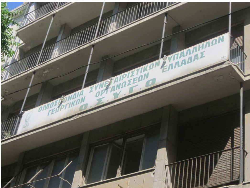
Εικόνα 17: πρόσοψη κτηρίου της οδού Μενάνδρου 48
