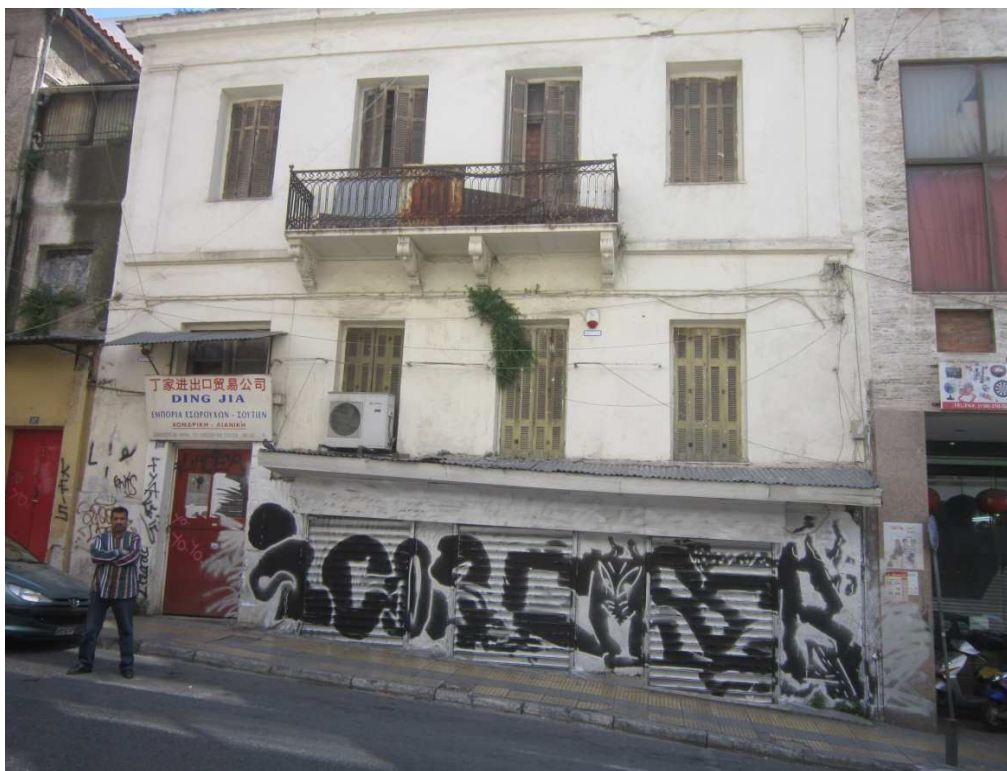
Εικόνα 19: πρόσοψη κτηρίου επί της οδού Σοφοκλέους 39
