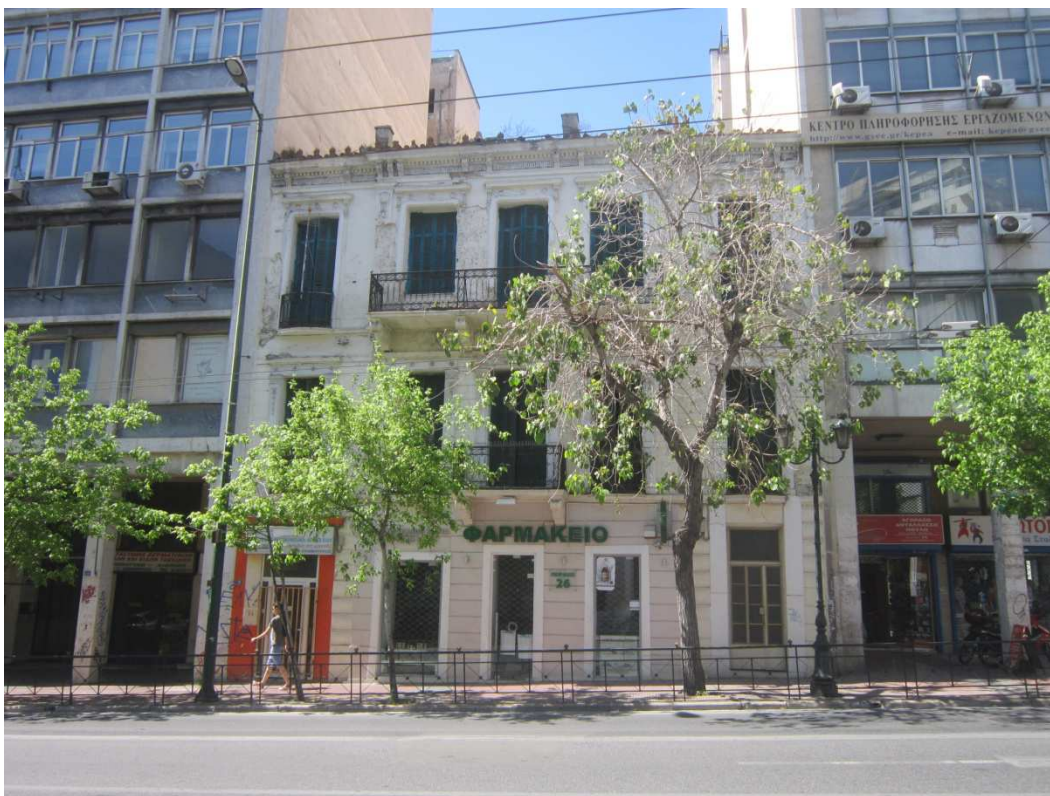
Εικόνα 9: πρόσοψη κτηρίου στην οδό Πειραιώς 26
