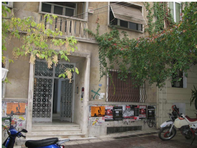
Εικόνα 11: είσοδος κτηρίου επί της οδού Βαλτετσίου 60
