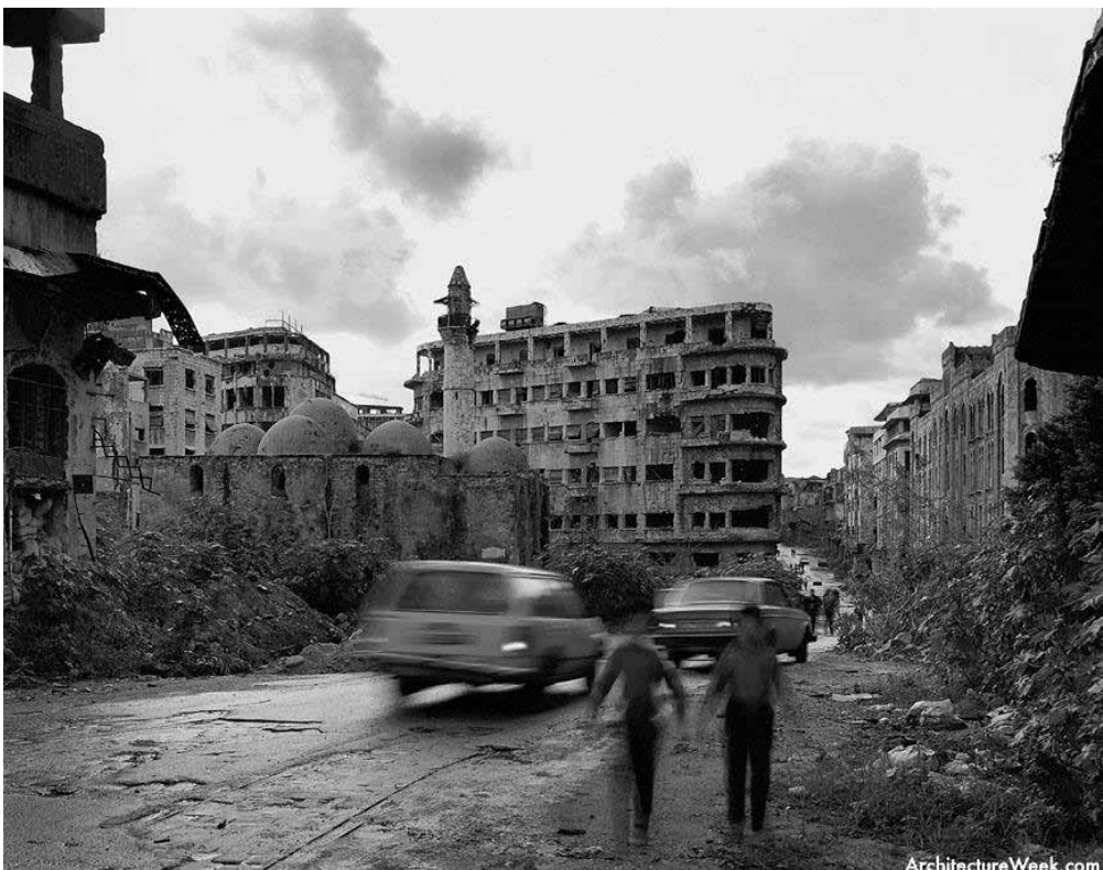
Εικόνα 6 Βηρυτός. Η εικόνα της πόλης μετά τον πόλεμο. Πηγή: Khoueiry Victor, Rebuilding central Beirut , στο Architecture Week , December 2000, http://www.architectureweek.com/2000/1220/building_1-1.html
