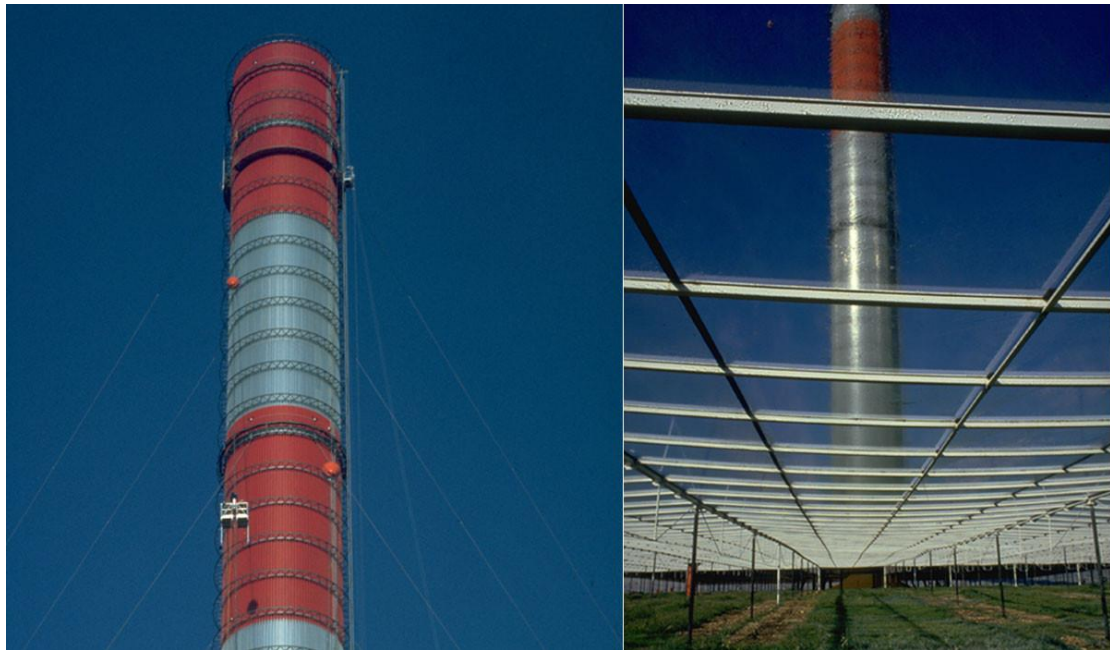
Εικόνα 2.5&2.6: Η καμινάδα και η δομή του ηλιακού συλλέκτη του σταθμού στην Ισπανία.
