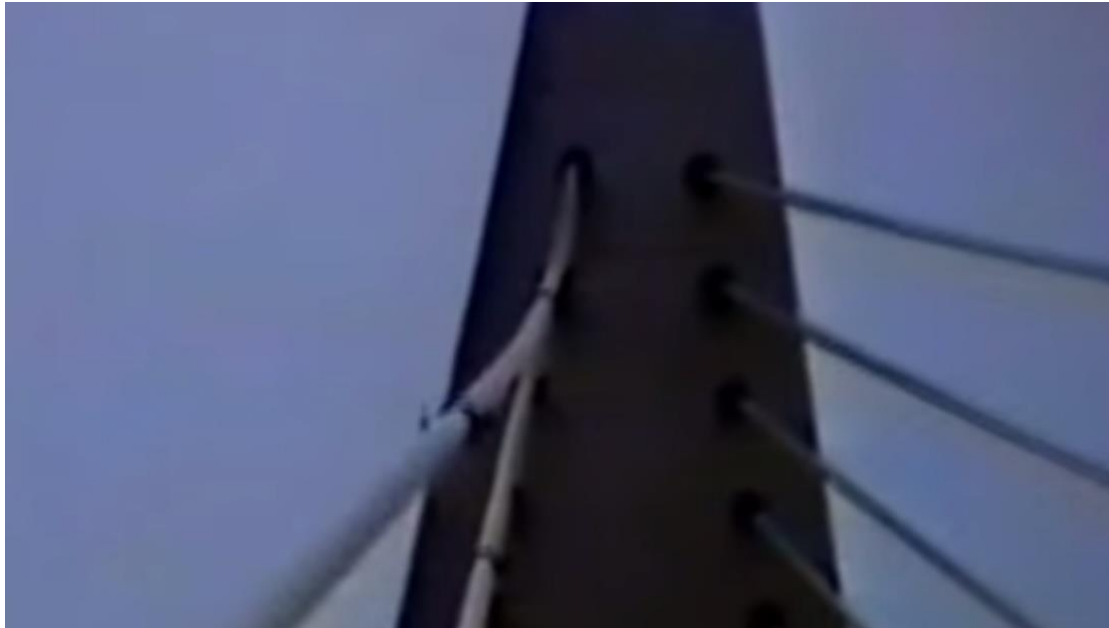
Εικόνα 4.6: Κρεμαστή γέφυρα στο Texas 1997.
