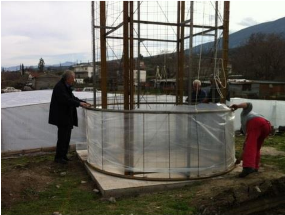
Εικόνα 3.4: Κατασκευή της καμινάδας του πειραματικού σταθμού στους Κομποτάδες.
