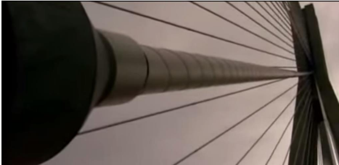
Εικόνα 4.12: Καλώδια της γέφυρας Ρίου-Αντιρρίου, στα οποία έχει εφαρμοστεί η λύση της περιέλιξης.
