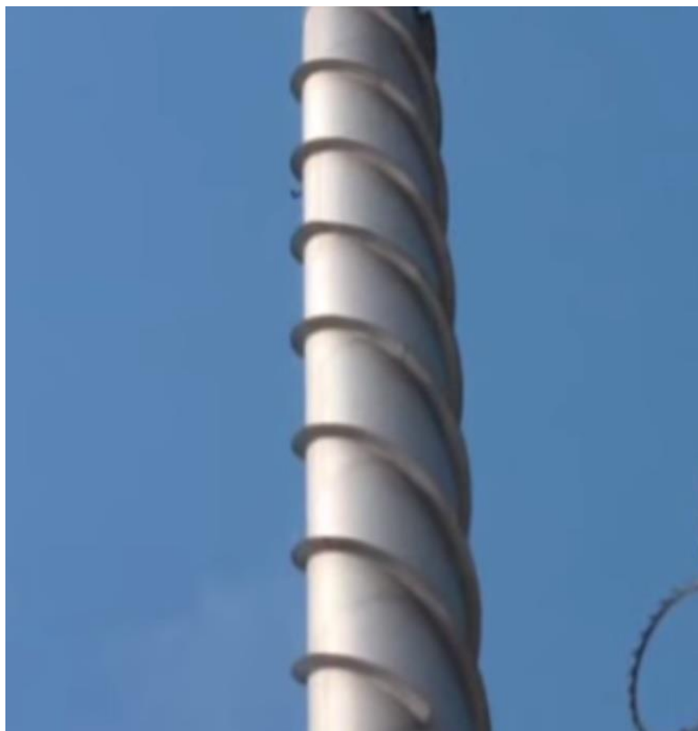
Εικόνα 4.11: Ενδεικτική περιέλιξη καμινάδας.
