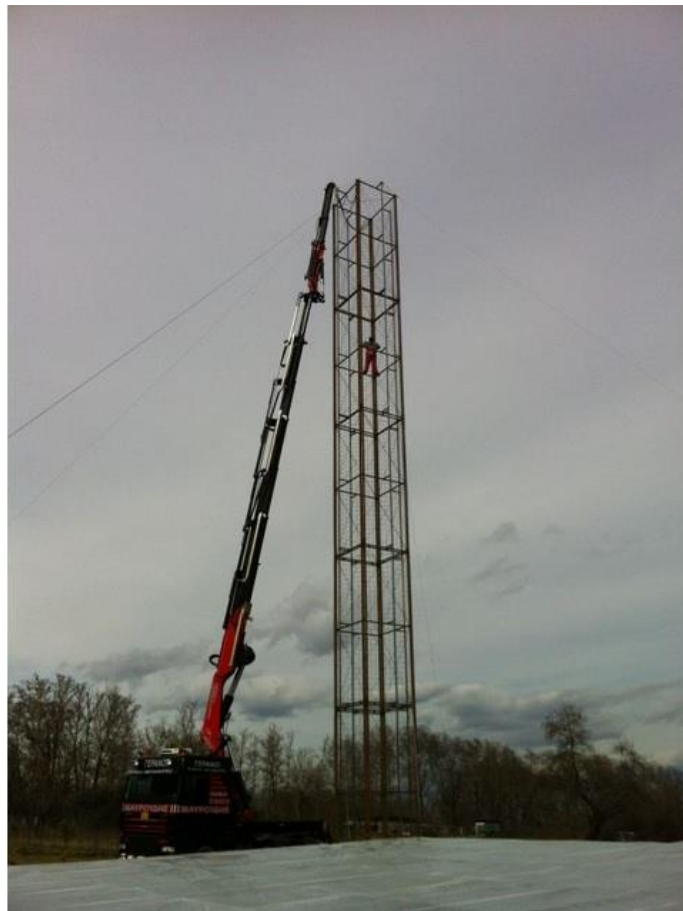
Εικόνα 3.3: Ανύψωση καμινάδας πειραματικού σταθμού στους Κομποτάδες.
