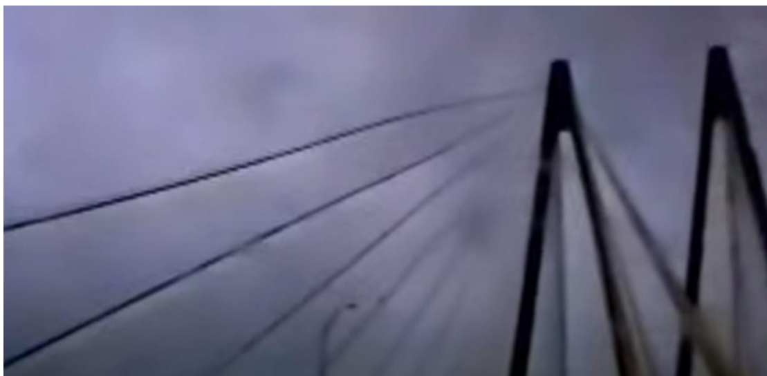
Εικόνα 4.7: Κρεμαστή γέφυρα στο Texas 1997.
