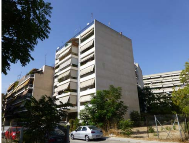
Εικόνα 5.4. Πολυόροφες οικοδομές των τελευταίων δύο δεκαετιών στην οδό Τριανταφυλλοπούλου, πλησίον του παλαιού Βουστασίου και του αμαξοστασίου του μετρό.
