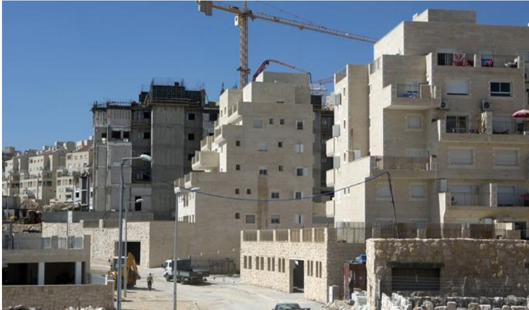
Εικόνα 2: Αυθαίρετο κτίσμα στην Ιταλία (ανακτήθηκε από www.linodore.blog.tiscali.it/page/8/?doing_wp_cron )
