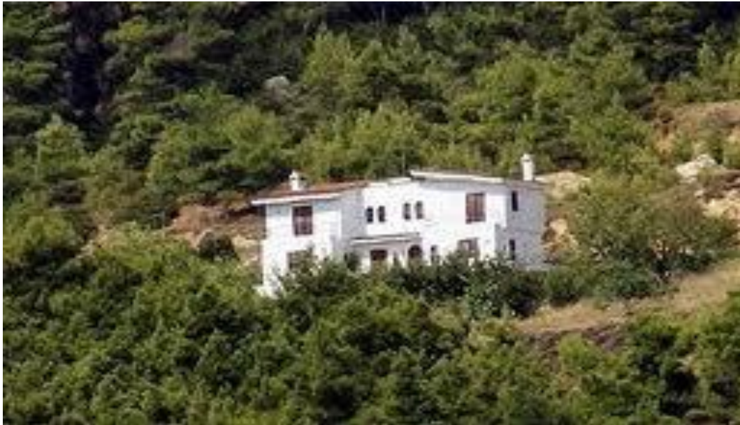
Εικόνα 14: Αυθαίρετο κτίσμα (ανακτήθηκε από www.iskra.gr )
