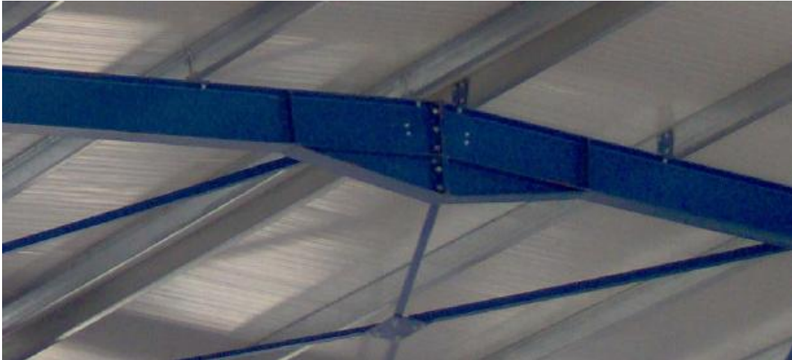
Εικόνα 1.4 Ενίσχυση στον κόμβο των ζυγωμάτων
