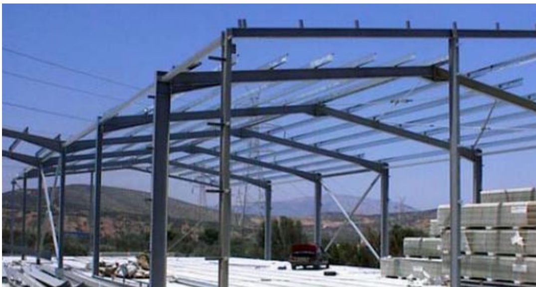
Εικόνα 1.2 Δίστηλα πλαίσια με ολόσωμα στοιχεία
