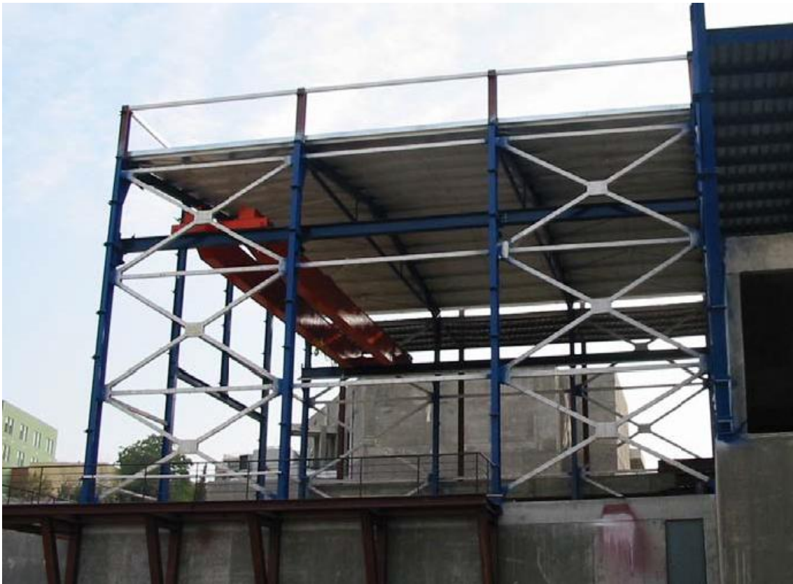
Εικόνα 1.8. Κατακόρυφα συστήματα δυσκαμψίας
