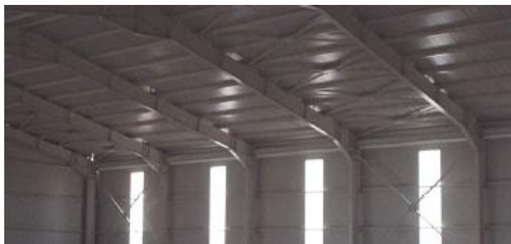
Εικόνα 1.5 . Οριζόντιοι σύνδεσμοι δυσκαμψίας
