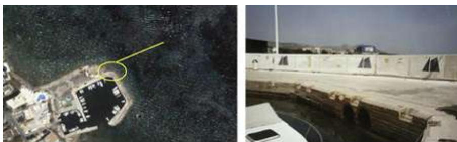
Σχήμα 2.4.3 Αγωγοί ανανέωσης στο Μάτι
