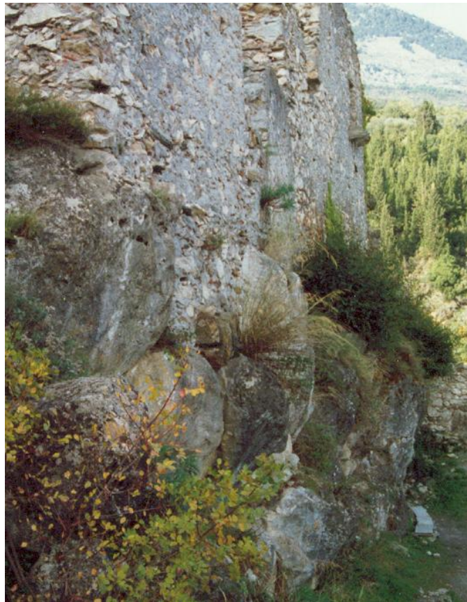
Φωτ. 1.4:Θεμελίωση οικοδομήματος πάνω σε ογκόλιθους. Σε περίπτωση απομάκρυνσης των ογκολίθων, η ανωδομή απειλείται με κατάρρευση [Μαριολάκος Η. , Λέκκας Σ. , κ.α., 1991]
