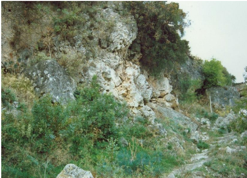
Φωτ. 1.3: Πάνω στο μονοπάτι που οδηγεί στην Παντάνασσα κοντά στην πόλη Μονεμβασιάς παρατηρούνται χαλαρωμένα πλευρικά κορήματα εξαιτίας των ασυνεχειών. [Μαριολάκος Η., Λέκκας Σ., κ.α., 1991]
