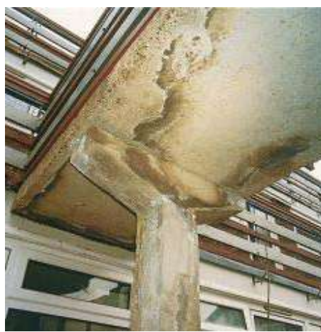
Σχήμα 33: Διάβρωση οπλισμών από χλωριόντα εκχιονιστικών αλάτων
