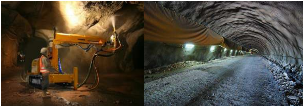
Σχήμα 20: Χρήσεις ινοπλισμένου σκυροδέματος για υποστήριξη σηράγγων
