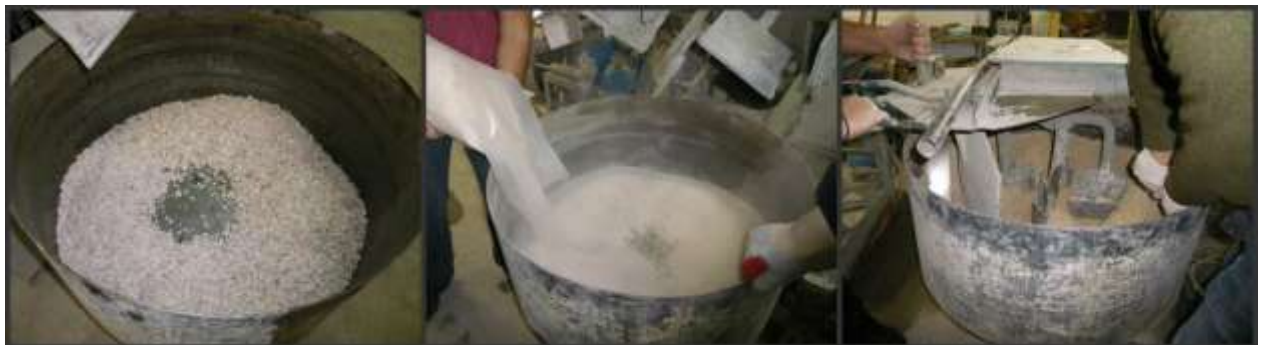
Σχήμα 40: Προσθήκη αδρανών υλικών, νερού και ανάδευση
