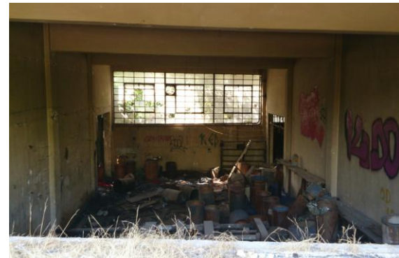
Εικόνα 53: Χώρος στο ισόγειο με χαρακτηριστικά τα μεταλλικά κουφώματα
