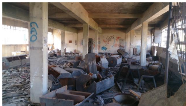
Εικόνα 49: Ο κάναβος είναι εμφανής σε όλους τους ορόφους και ειδικά στον τρίτο
