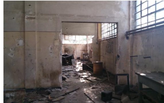
Εικόνα 52: Ο εγκαταλελειμμένος χώρος πρώην βιομηχανικής χρήσης στο ισόγειο
