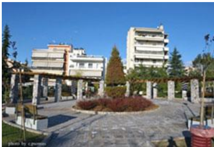
Εικόνα 8 : Πλατεία Βεάκη μετά την ανάπλαση της.
