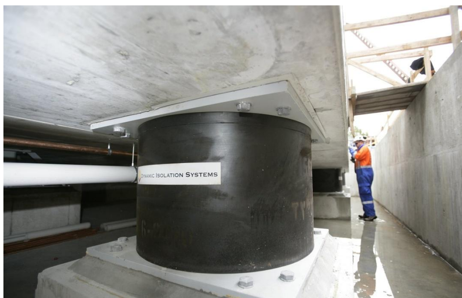
Σχήμα 1.24: Ελαστικό Εφέδρανο σε Ανέγερση Κτιριακής Εγκατάστασης [93]
