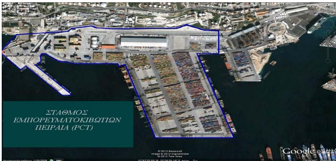
Σχήμα 4-7: Ο Σταθμός Εμπορευματοκιβωτίων Πειραιώς στην Προβλήτα II (ΣΕΠ)
