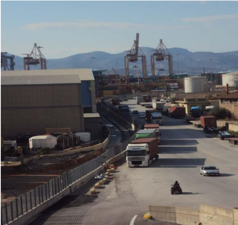
Σχήμα 4-11: Κατασκευή Γραμμής τρένου στον Σ.ΕΜΠΟ για σύνδεση με το Θριάσιο
