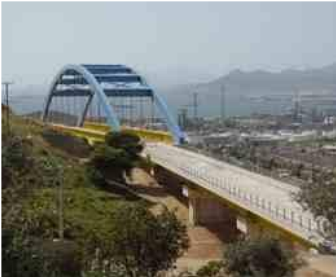
Σχήμα 5-9: Σιδηροδρομικά έργα στο Ν.Ικόνιο-Θριάσιο
