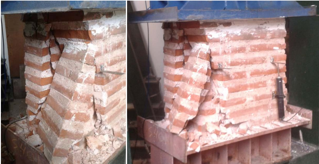
Εικόνα 3.10 Δοκίμο LCem 2 – Όψη D - Όψη Α.
