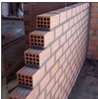
Εικόνα 2.4 – Δρομική και μπατική οπτοπλινθοδομή.
