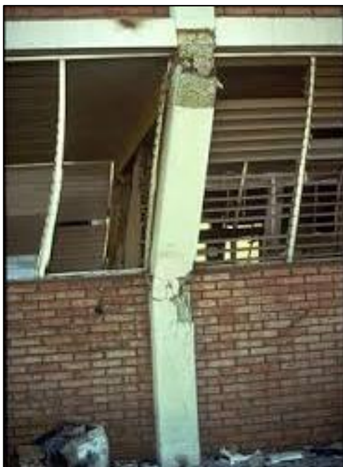
Εικόνα 1.6 – Ενδεικτικές αστοχίες κοντών υποστυλωμάτων κατά το σεισμό.
