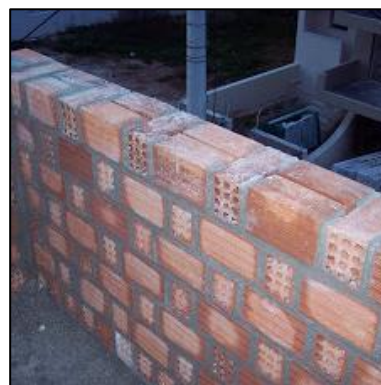
Εικόνα 2.4 – Δρομική και μπατική οπτοπλινθοδομή.
