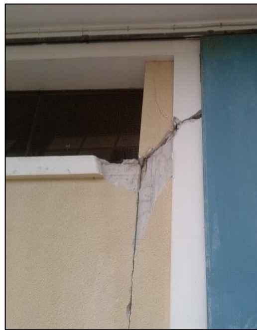
Εικόνα 1.6 – Ενδεικτικές αστοχίες κοντών υποστυλωμάτων κατά το σεισμό.
