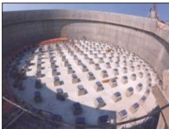
Εικόνα 1.10: Τοποθέτηση εφεδράνων στη βάση της δεξαμενής LNG
