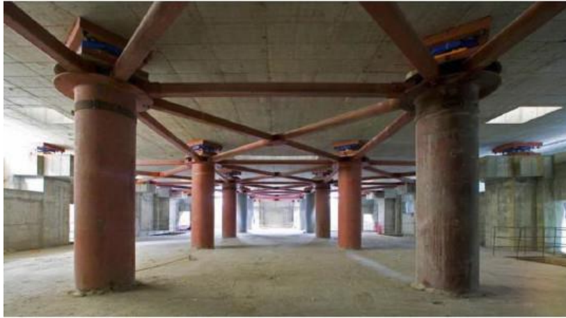
Εικόνα 1.11: Στάθμη σεισμικής μόνωσης
