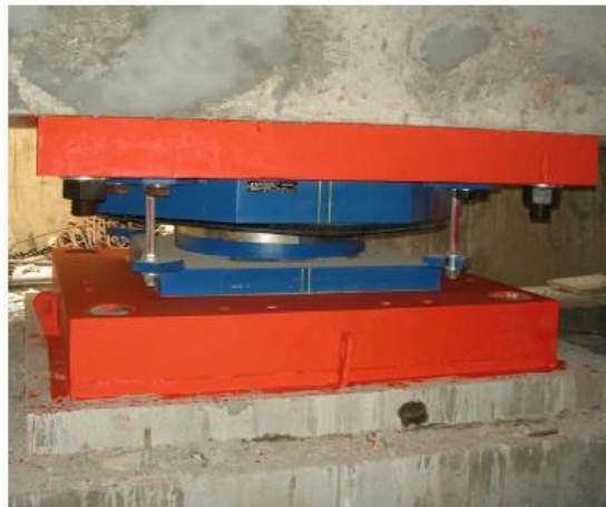
Εικόνα 1.12: Τοποθετημένο εφέδρανο
