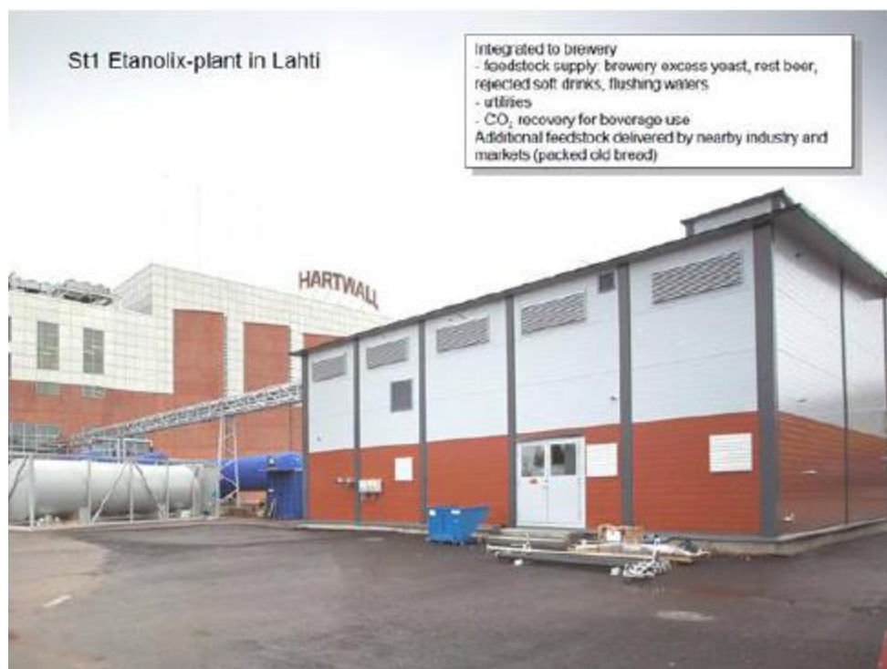
Εικόνα 4.5: Μονάδα St1 Etanolix, Lathi (Πηγή: St1 – Biofuels, 2012)
