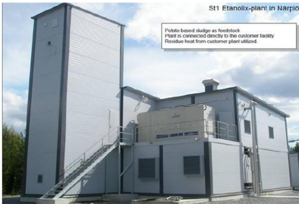
Εικόνα 4.3: Μονάδα St1 Etanolix, Narpio (Πηγή: St1 – Biofuels, 2012)
