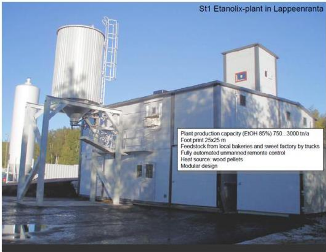
Εικόνα 4.2: Μονάδα St1 Etanolix, Lappeenranta (Πηγή: St1 – Biofuels, 2012)
