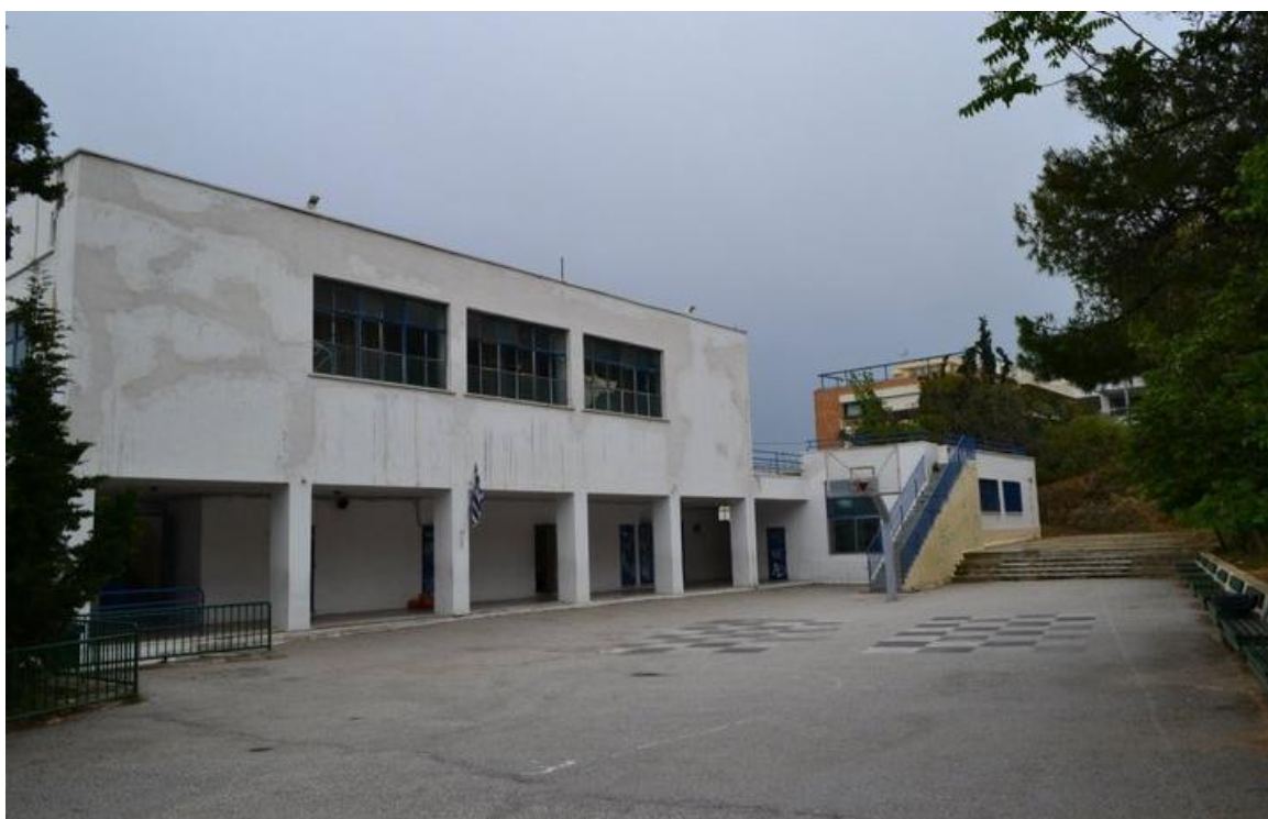
Φωτογραφία 12: Το κεντρικό κτίριο του σχολικού συγκροτήματος που φιλοξενεί μαθητικές αίθουσες και τα γραφεία των εκπαιδευτικών
