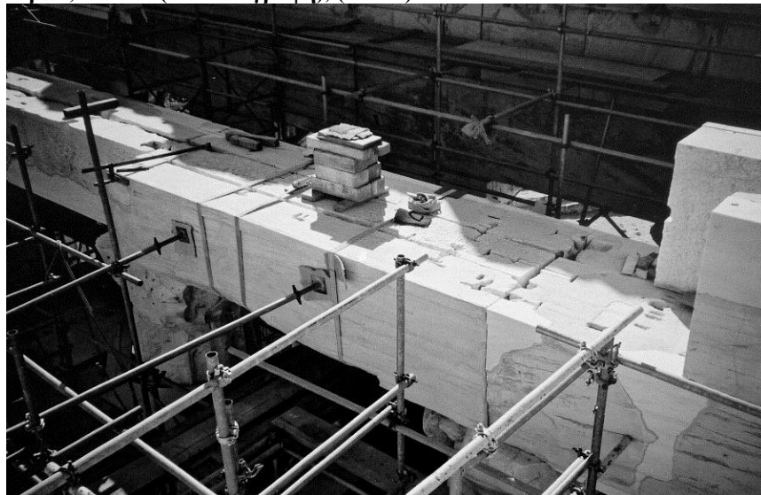
Εικόνα 1.19 Μετακίονιο 3(ΟΕ3.1-3.3) κατά την αναστύλωση (φωτ. Ε.-Ε.Τουμπακάρη). Είναι εμφανής ο τρόπος σύνδεσης των επιστυλίων στην άνω έδρα τους κατά την διαμήκη και την εγκάρσια διεύθυνση με χρήση συνδέσμων διπλού ταυ.
