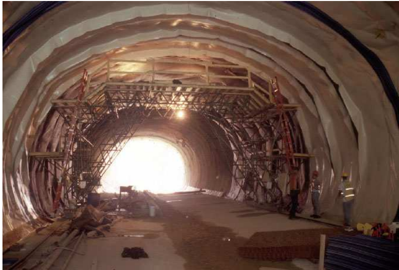
Εικόνα 1.1 Τοποθέτηση γεφυφάσματος και στεγανωτικής μεμβράνης
