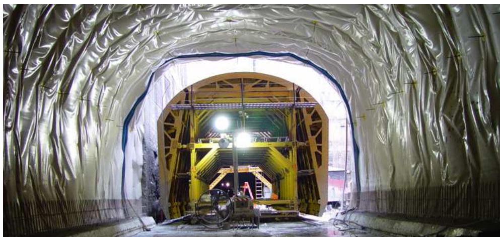
Εικόνα 1.3 Καλούπι για τη σκυροδέτηση της τελικής επένδυσης (κελώνα)
