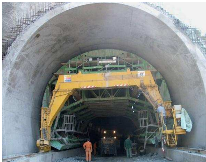
Εικόνα 2.5 Μεταλλότυπος για τη σκυροδέτηση της τελικής επένδυσης (κελώνα)
