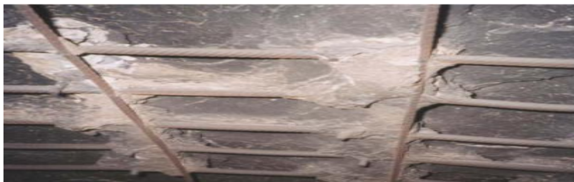
Εικόνα 2-3 Εκδηλώσεις αποφλοίωσης λόγω θερμικής επίθεσης
