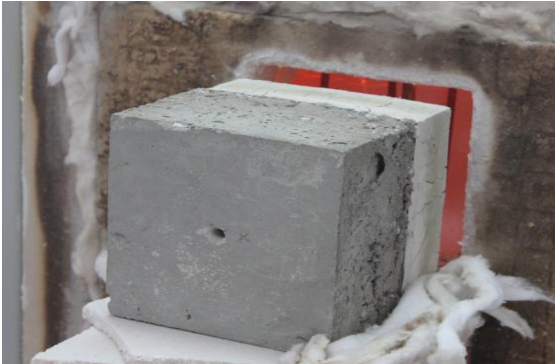
Εικόνα 4-30 Δοκίμιο δοκιμής παθητικής πυροπροστασίας (σκυρόδεμα + γεωπολυμερές υλικό), μετά την δοκιμή
