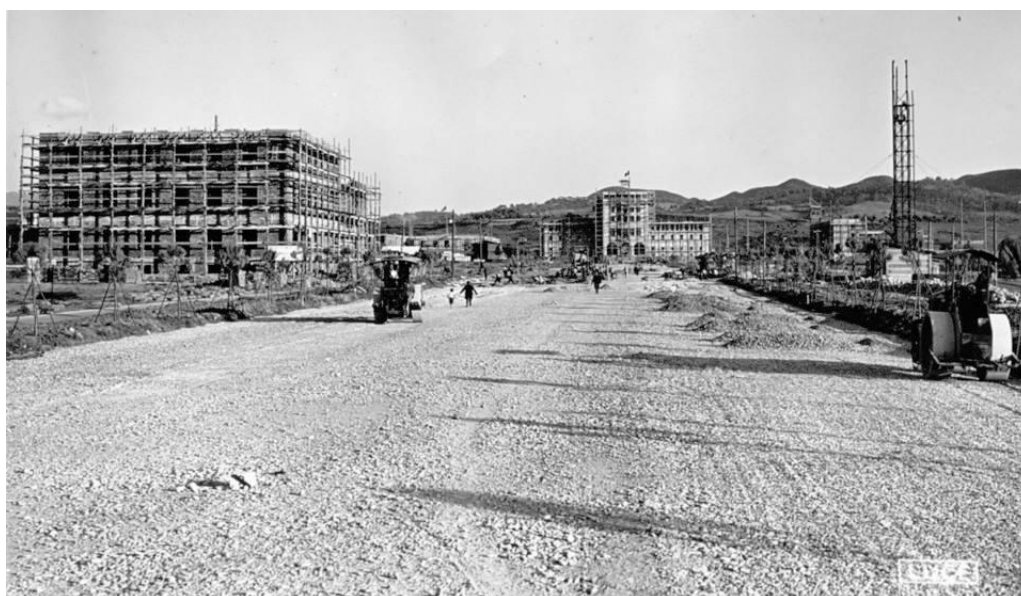
Εικόνα 43. Κατά την κατασκευή του μνημειακού χώρου του « Piazza Littoria ». Στο βάθος διακρίνονται: το κτίριο Casa del Fascio και αριστερά, το κτίριο της Opera Nazionale Dopolavoro Albanese , του ιταλού αρχιτέκτονα Gherado Bossio, Τίρανα, 1941.
