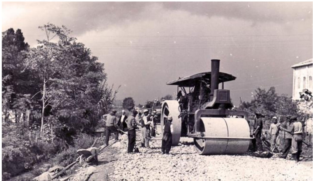
Εικόνα 16. Κατασκευή της οδού Τιράνων - Δυρραχίου.
