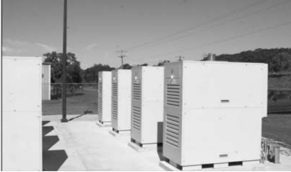
Σχήμα 1.2 Μικροτουρμπίνες 30kW [3]
