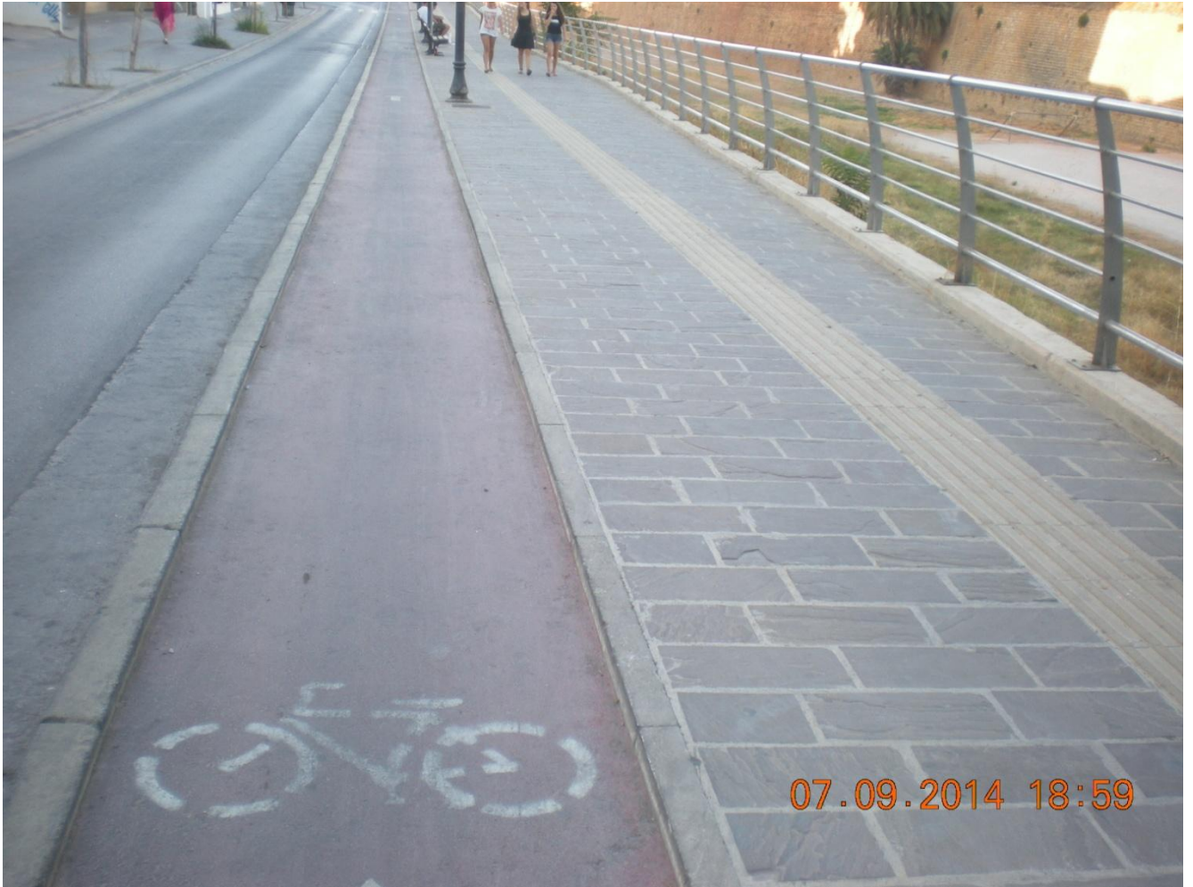
Εικόνα 3.4 Ποδηλατόδρομος οδού Πειραιώς
