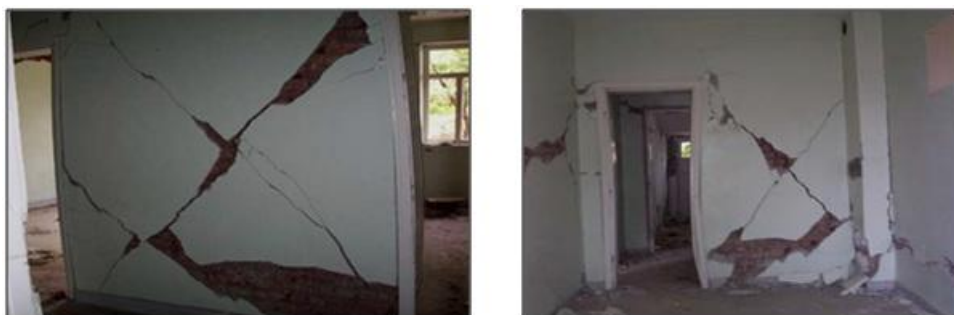
Σχήμα 2.5: Βλάβητοιχώματοςλόγωαπουσίαςεγκάρσιας υποστήριξης (Doğangünetal 2008)
