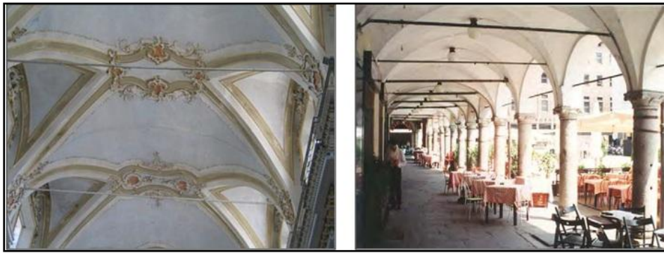
Σχήμα 4.4: Χρήσηελκυστήρωναπόμεταλλικέςράβδους σε τόξα (Rashdul 2008)
