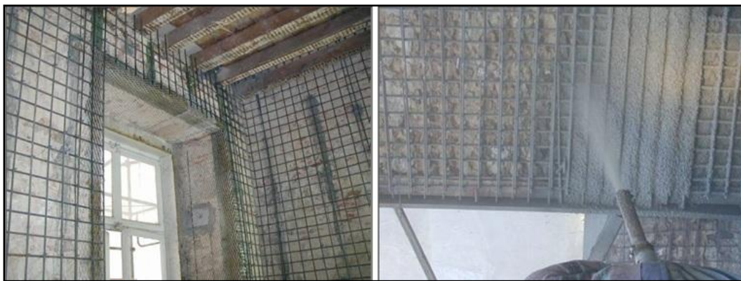
Σχήμα 4.2: Τοιχοποιία ενισχυμένη με μεταλλικό πλέγμα στο εσωτερικό του κτιρίου (Rashadul 2008)
