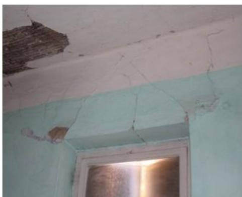
Σχήμα 5.9: Ρηγμάτωση υπέρθυρου στο εσωτερικό (W1-in, 1 ος όροφος) και εξωτερικό (W1-ex, 1 ος όροφος) του κτιρίου
