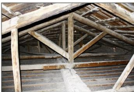
Σχήμα 5.7: Δικτύωμα κεντρικής στέγης
