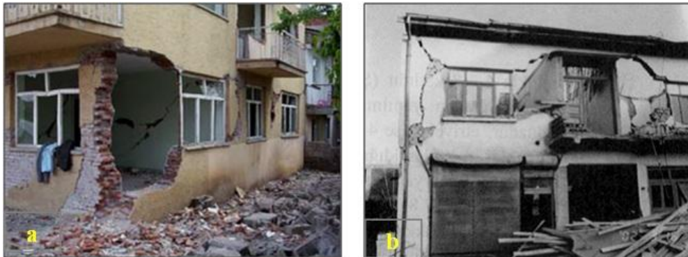
Σχήμα 2.6: Κατάρρευση γωνίας και κατακόρυφη ρηγμάτωση κοντά στη γωνία κτιρίου από τοιχοποιία (Doğangün A. et al., 2008)
