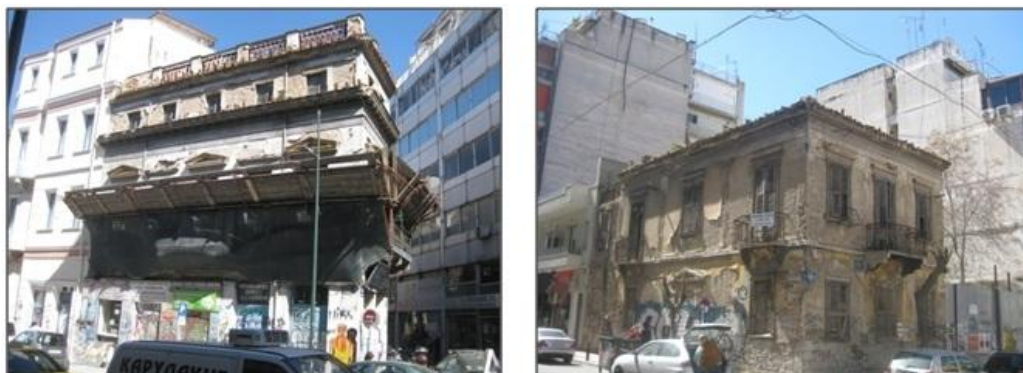
Σχήμα 1.5: Ιστορικά παραδοσιακά σπίτια. Διώροφες και τριώροφες κατοικίες με διαφορετικά υψόμετρα του πρώτου, δεύτερου και τρίτου ορόφου
