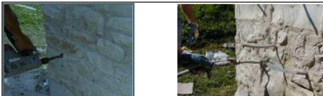
Σχήμα 4.1: Τεχνικές έγχυσης ρευστού τσιμεντοκονιάματος (Meireles and Bento 2013).
