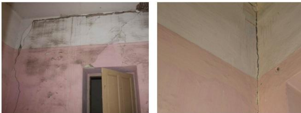
Σχήμα 5.10: Κατακόρυφη ρηγμάτωση στη σύνδεση τοίχων(W6-in, 1 ος όροφος)
