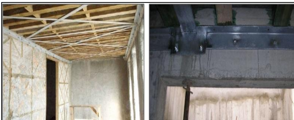
Σχήμα 4.7: Αύξηση δυσκαμψίας δαπέδου μέσω Προσθήκης κατασκευής από χιαστί τοποθετημένες ράβδους χάλυβα διατομής L .
