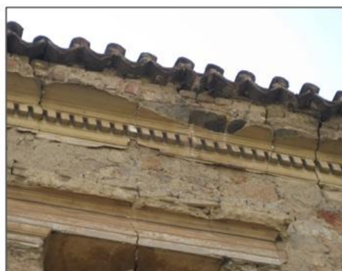
Σχήμα 5.9: Ρηγμάτωση υπέρθυρου στο εσωτερικό (W1-in, 1 ος όροφος) και εξωτερικό (W1-ex, 1 ος όροφος) του κτιρίου
