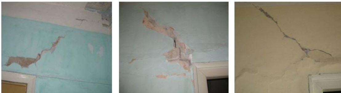
Σχήμα 5.11: Χαρακτηριστική διαγώνια ρηγμάτωση δευτερεύοντος τοίχου
