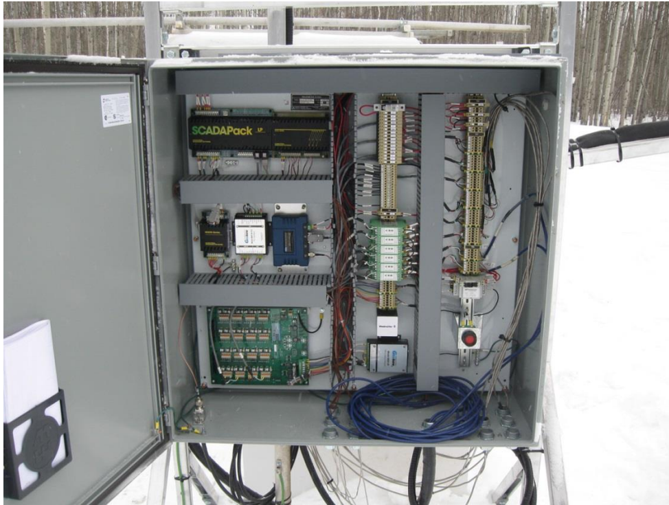
Σχήμα 2. 6 Εσωτερική εγκατάσταση RTU
