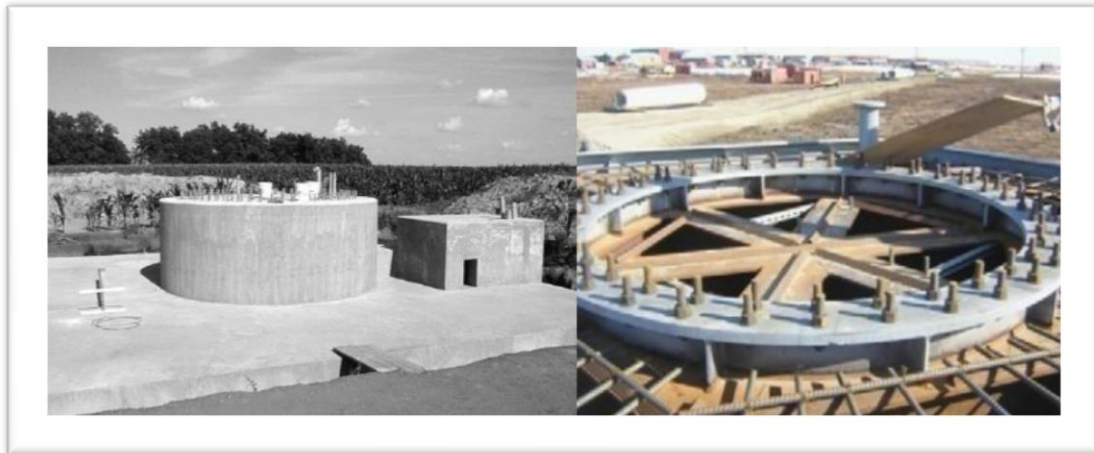
Εικόνα 3.1: Θεμελίωση μέσω εκτενούς πεδίου
