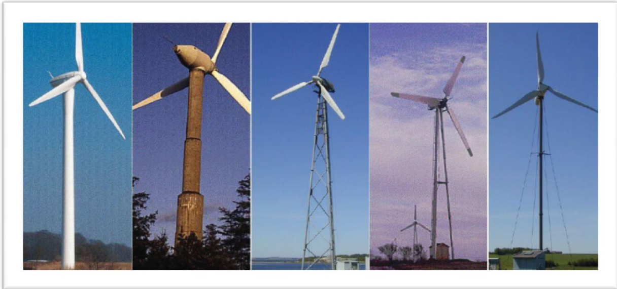
Εικόνα 2.1: Πιθανές διατομές του πύργου αιολικής μηχανής. Απεικονίζονται κατά σειρά: tubular steel tower, tubular concrete tower, lattice tower, three-legged tower, guy-wired pole tower
