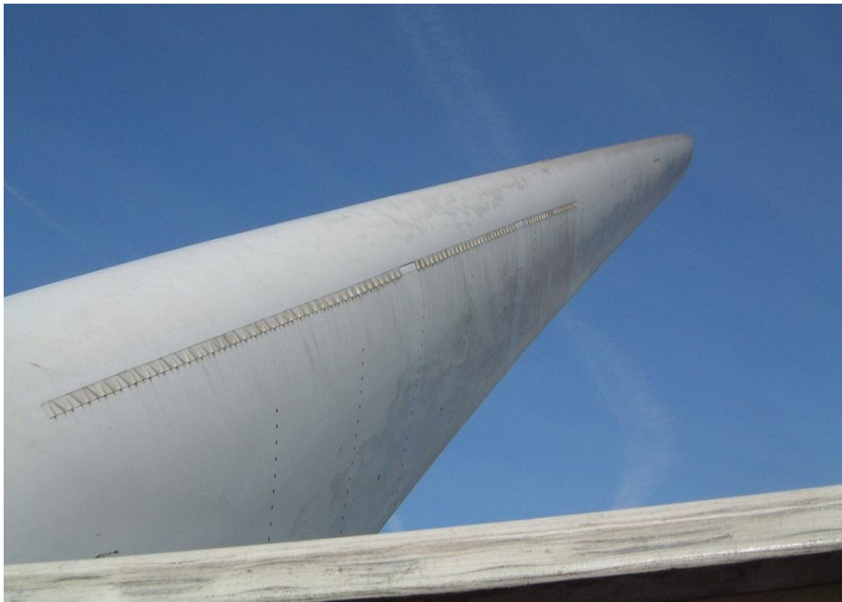
Εικόνα 1.5. VGs σε πτέρυγα ανεμογεννήτριας.
