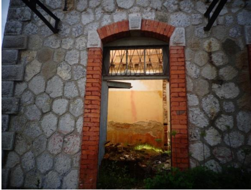
Φωτογραφία 1.10: Εξωτερική στρώση λιθοδομής (μωσαϊκή λιθοδομή)
