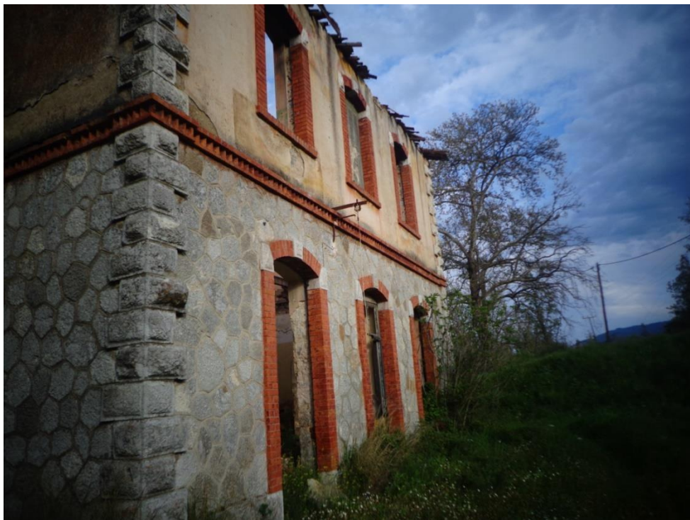
Φωτογραφία 1.8: Πίσω όψη κτιρίου (υπάρχουσα κατάσταση)
