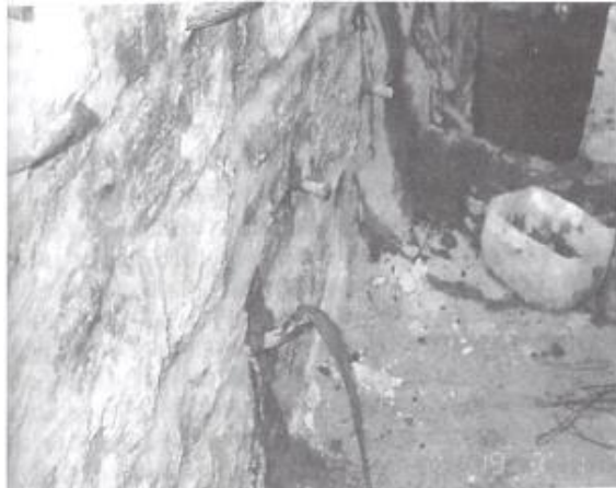
Εικόνα 5.4: Ένεμα εξερχόμενο από σωληνίσκο [1]
