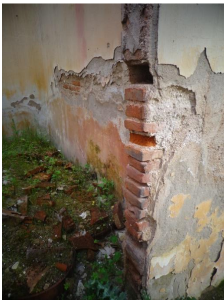
Φωτογραφία 1.12: Εσωτερικοί τοίχοι από συμπαγή τούβλα (υπάρχουσα κατάσταση)
