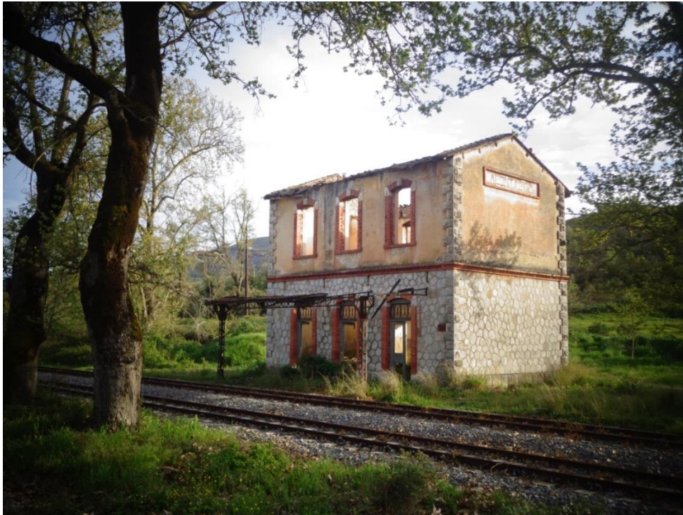
Φωτογραφία 1.5: Κτίριο σταθμού επιβατών (υπάρχουσα κατάσταση)
