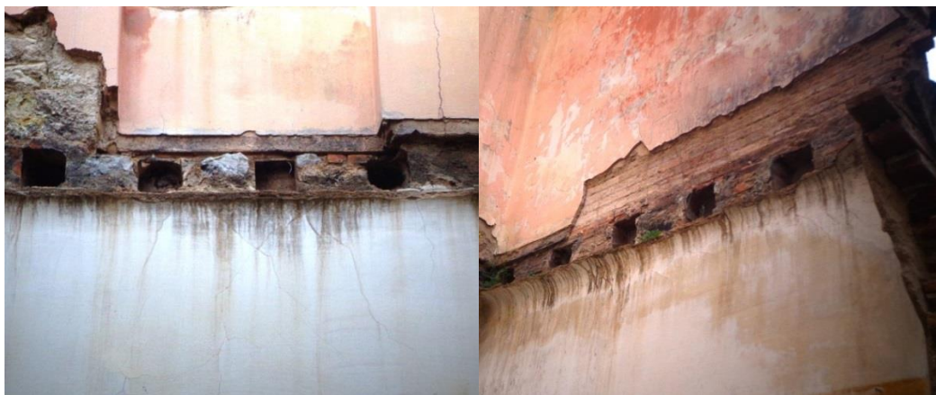
Φωτογραφίες 1.14-1.15: Οπές λίθινων τοίχων-δοκοθήκες για την στήριξη των ξύλινων δοκαριών του δαπέδου
