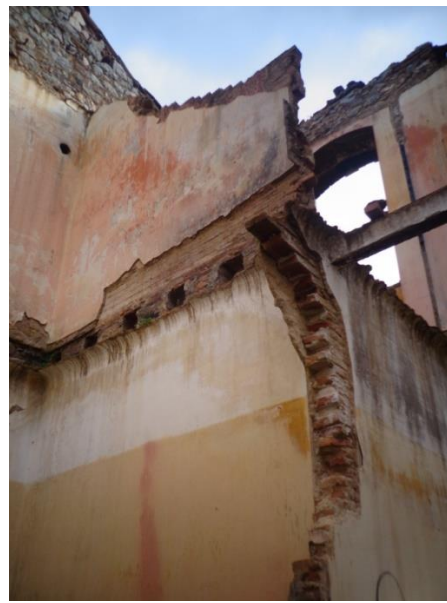
Φωτογραφία 1.13: Τοίχοι κλιμακοστασίου (υπάρχουσα κατάσταση)
