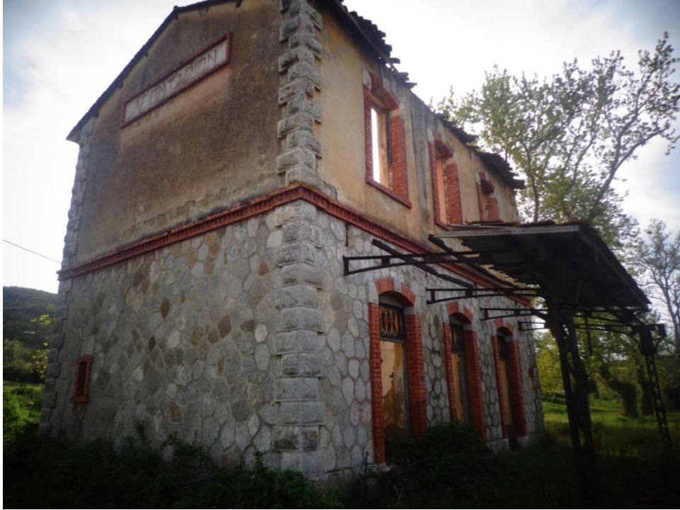
Φωτογραφία 1.9: Μπροστά και πλάγια όψη κτιρίου (υπάρχουσα κατάσταση)
